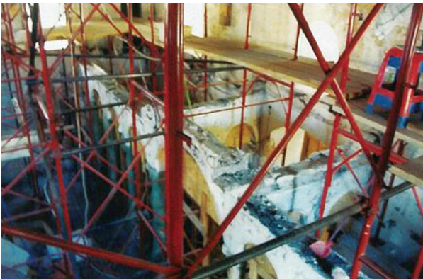
Fotoğraf 6. Fatih (Çarşı-Bayraklı) Camisi'nde 2002 yılında yapılan restorasyon çalışmalarından, mahfilin onarımı (İbrahimgil-Konuk 2006).
