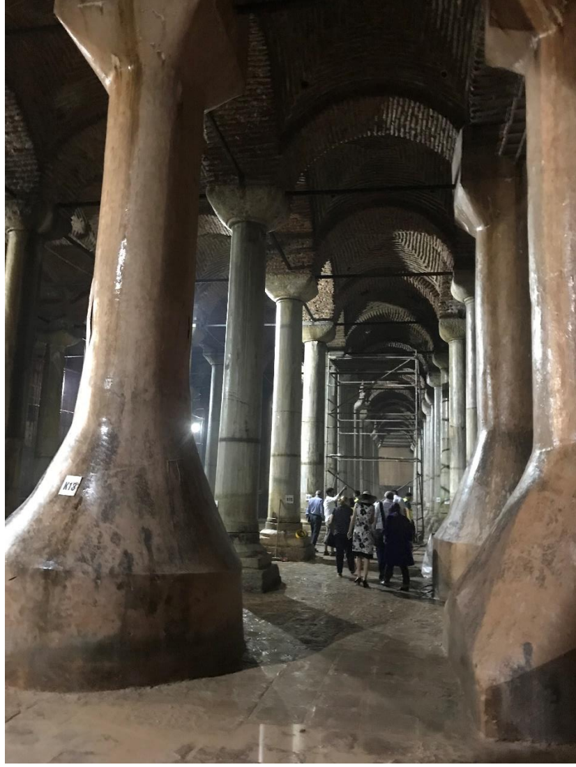
Şekil 4. 19. Betonarme ile güçlendirilmiş fil ayağı şeklinde olan sütunlara bakış
