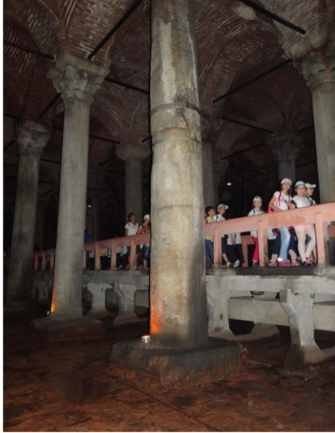
Şekil 4. 80. Şakül kayması olan sütun örneği
