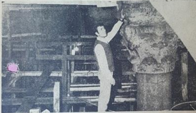
Yerebatan Sarayı'nın delinerek sarnıcı içine atılan temellerden birini inşaat işçilerinden bir tanesinin gösteriyor.
