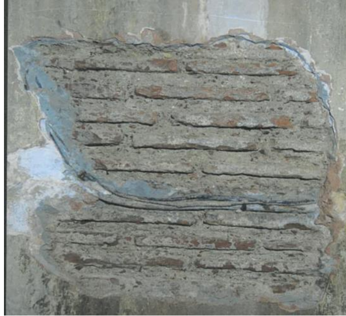
Şekil 4. 89. Beden duvarında Raspa araştırması (Hera Rest. A.ş Arşivi)
