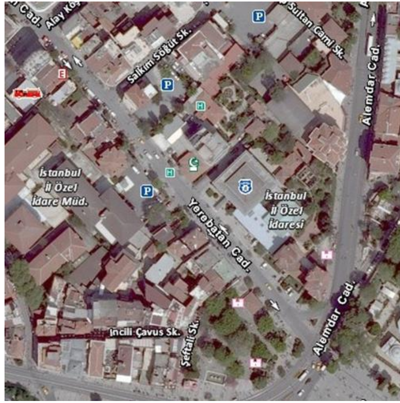
Şekil 4.56. Yerebatan Sarnıcı üzerinde yapılmış ve sonradan yıkımına karar verilmiş İstanbul İl Özel İdare Binası'nın kuşbakışı görünüşü (Hera Rest. Arşivi)
