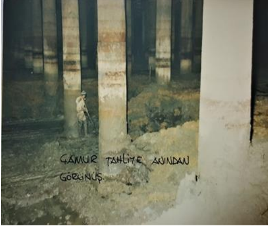
Şekil 4. 45. Çamur tahliye anında çekilmiş fotoğraf
