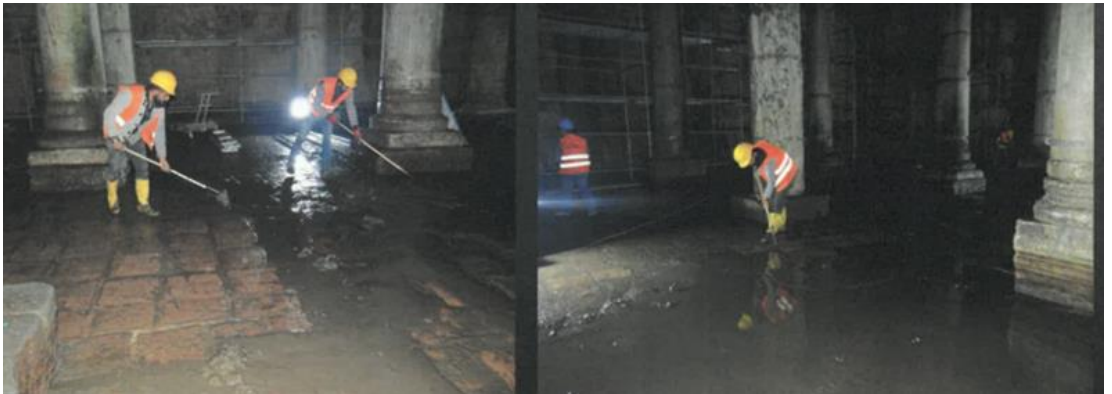
Őekil 4. 72. Suyun tahliyesi çalışmaları ( Hera Rest. Arőivi )
