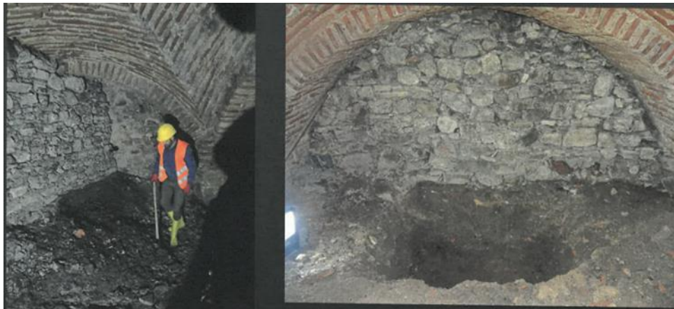
Şekil 4. 84. Kapatılan alanda yapılan araştırma kazıları ( Hera Rest. Arşivi )
