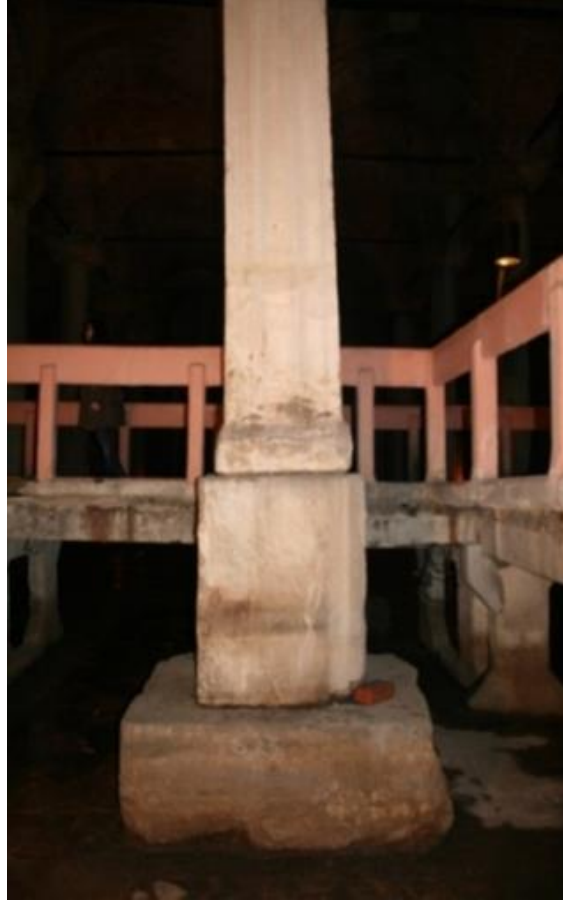
Şekil 2. 38. Alçak kalan sütunun eklemeye yapılarak yükseltilmesi örneği
