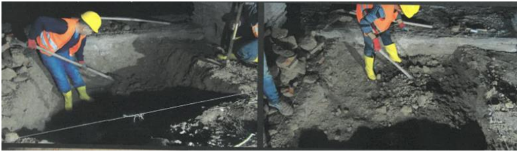
Şekil 4. 86. Kapatılan kısım duvarları arasında yapılan araştırma açmaları (Hera Rest. Arşiv).
