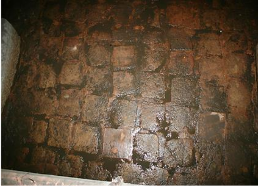
Şekil 2. 27. Zemin tuğla döşeme detayı
