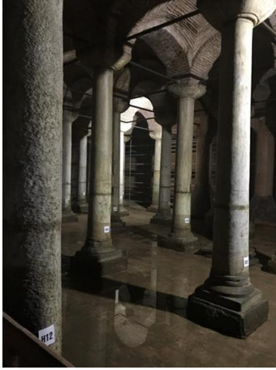
Şekil 4. 73. Sarnıç içerisinde beton payeli kolonların olduğu alana bakış
