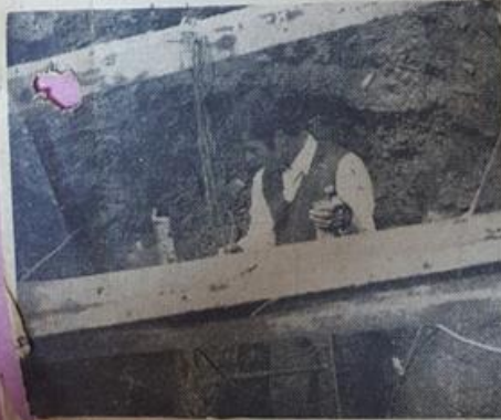
Yerebatan Sarayı'nın sarnıcındaki temel çalışmaları görülüyor.
