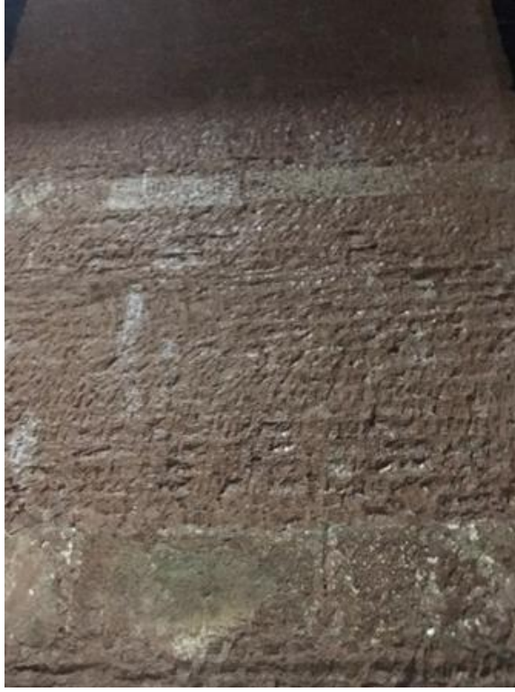
Şekil 4. 96. Osmanlı dönemi tuğla ile kapatılan kolonlarda raspa çalışmaları
