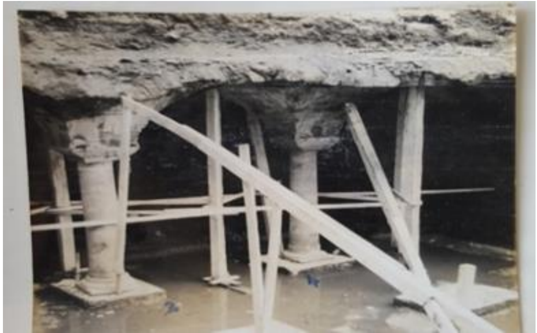
Şekil 4. 29. Sütunların ahşap destek takviyesi ile koruma altına alınması
