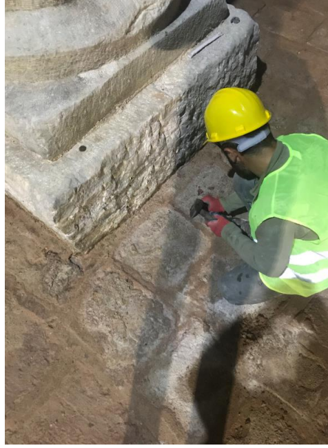
Şekil 4. 90. Tuğla zemin döşeme derz temizliği öncesi
