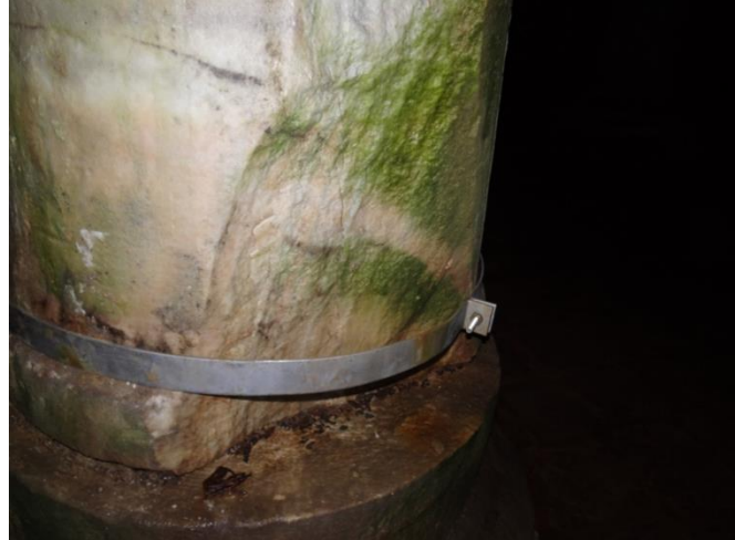
řekil 4. 78. Malzeme kaybı olan stun detayı
