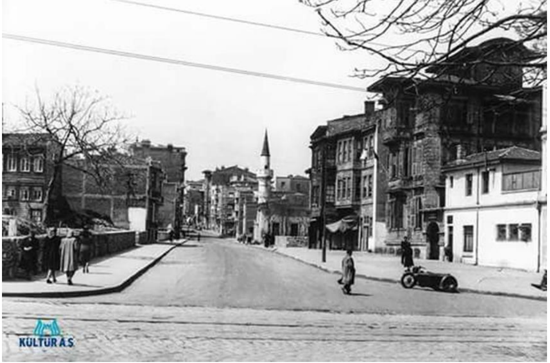
Şekil 4. 40. Mese Caddesi üzerinden Yerebatan Caddesi'ne bakış, sağ tarafta Turşucuzade Konağı görülmektedir.(URL-19)
