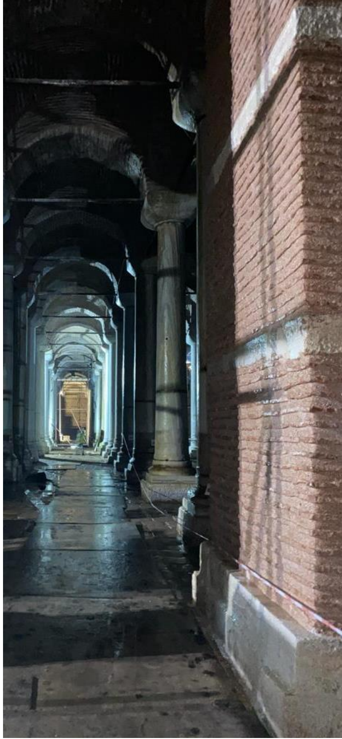
Şekil 4. 95. Osmanlı döneminde koruma altına alınmış tuğla ile kapatılmış sütunlarda raspa çalışmaları
