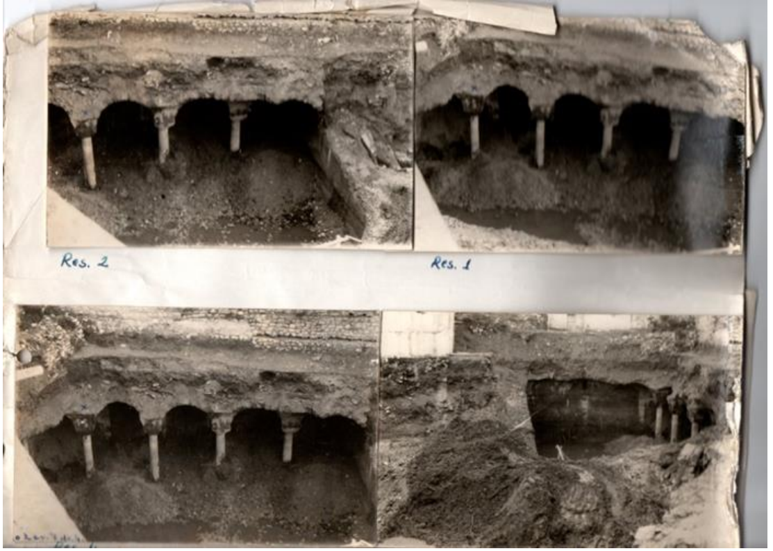
Şekil 4. 32. Hafriyat sonrası açığa çıkan sütunlar
