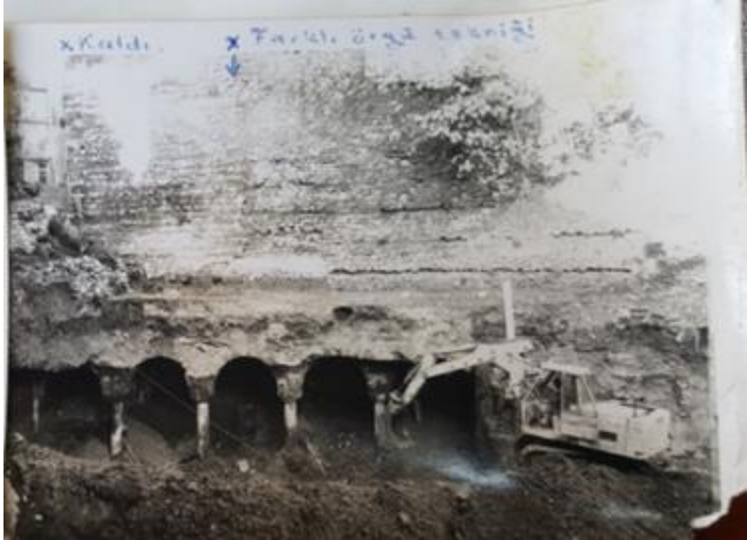
Şekil 4. 31. Yıkılan duvar hafriyatının alımı
