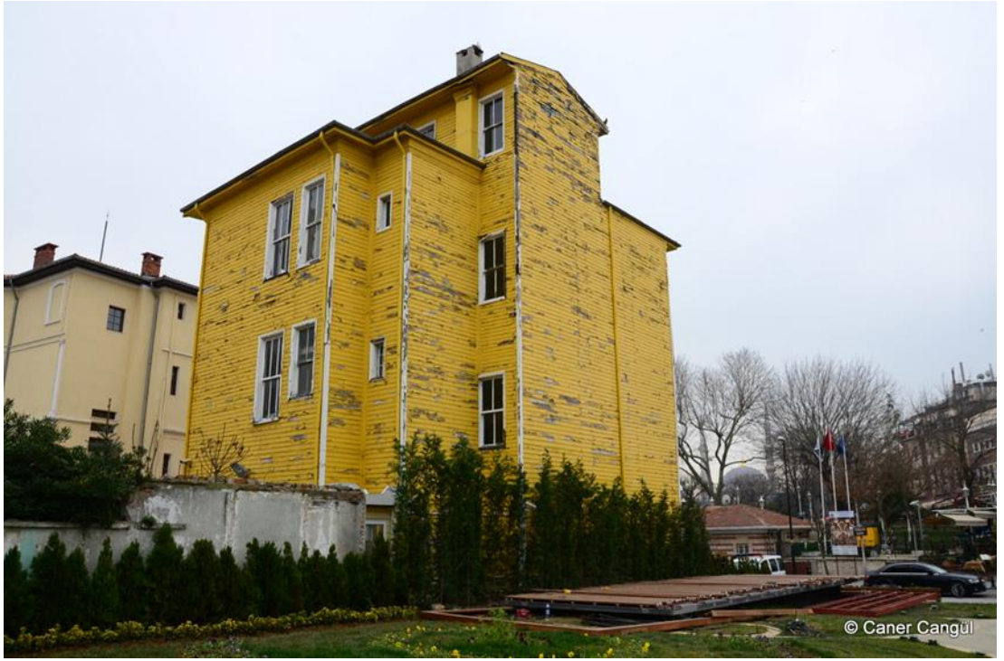
Şekil 4. 39. Turşucuzade Konağı arka cephe (Caner Cangül 2014).(URL-18)
