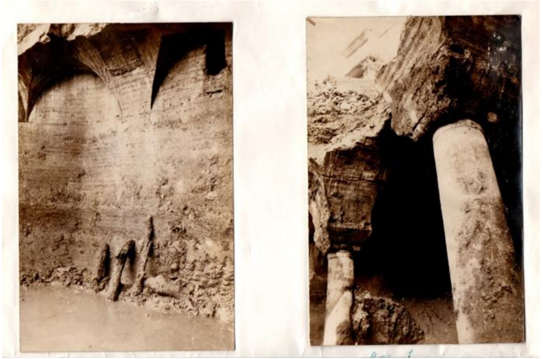
Şekil 4. 33. Hafriyat sonrası açığa çıkan sütın başlık detayı
