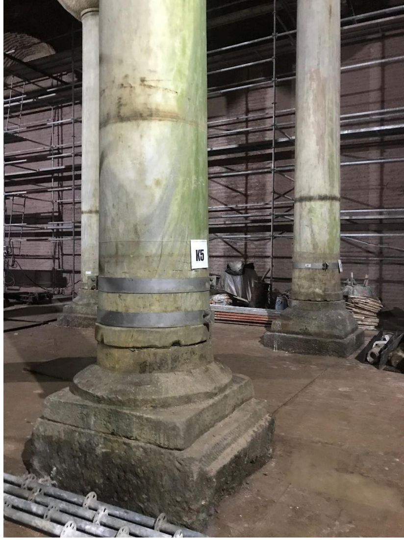
Şekil 4. 82. Uygulama öncesi sarnıç içerisinde kurulan iskeleler
