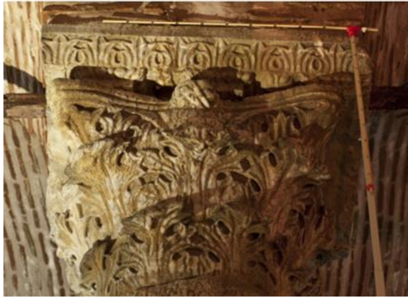
Şekil 2. 39. Yerebatan Sarnıcında İmpost Başlık Olarak Kullanılan Saçaklık Parçası (Özer Özsarı-Sibel Özbilgiç)
