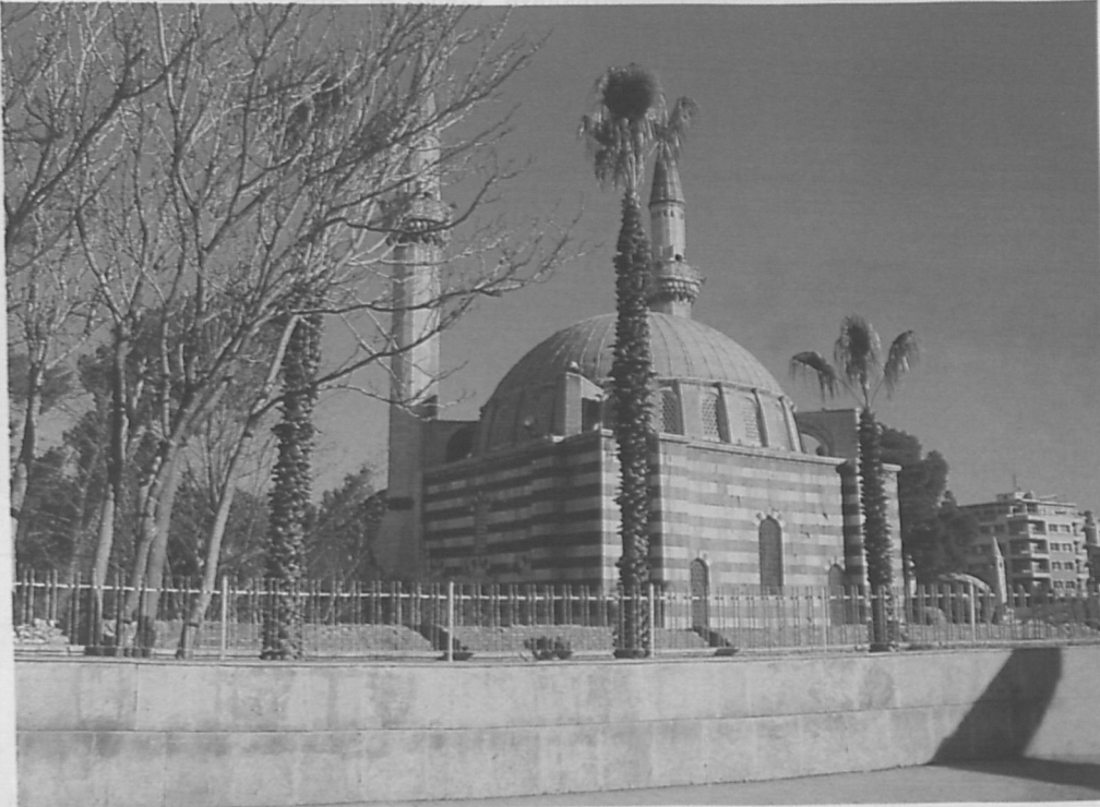
Lev. 10: ŞAM, Süleymaniye Külliyesi, Güney Cephe (Müderrişođlu 2003).
