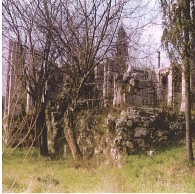
Şekil 3.12. Mehmed Paşa Köşkü'nün (Sancak Köşkü) güney doğu cephesini gösteren görsel. (Çetiner, 1996, sy. 211.)
