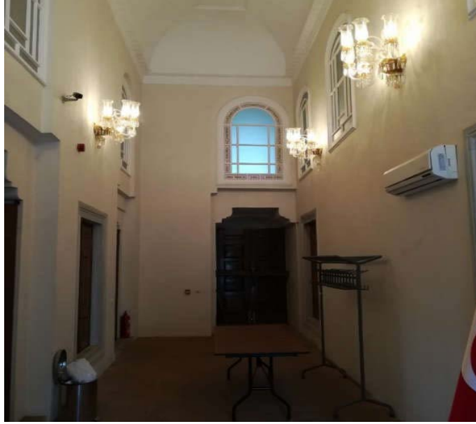
Şekil 3.15.Hünkâr Kasrı Zemin Kat Koridor.
