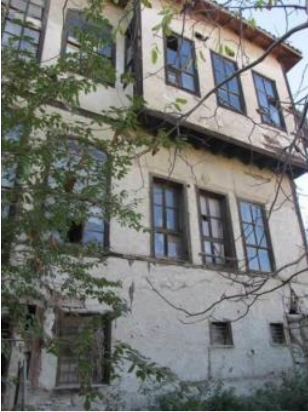
Şekil 34 Uşakizade Konağı Güney cephesi, Kütahya
