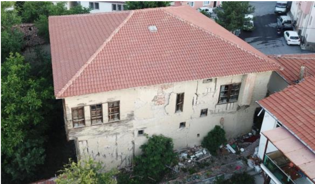
Şekil 33 Uşakizade Konağı, Kütahya
