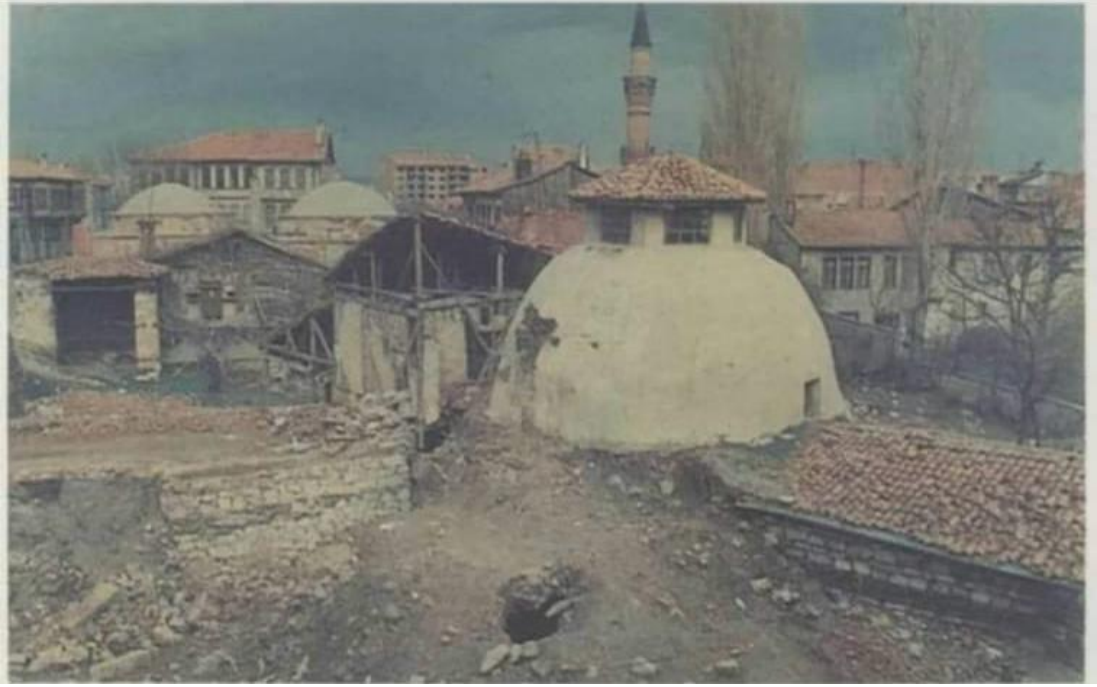
Şekil 23 (Şeyh Bahşi Tekkesi, Dere taşması sebebiyle toprak altında kalan alanlar, E.Altıntaş)
