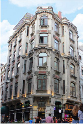
Ragıp Paşa Apartmanı
