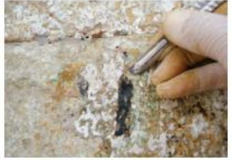
Mekanik temizleme uygulaması
