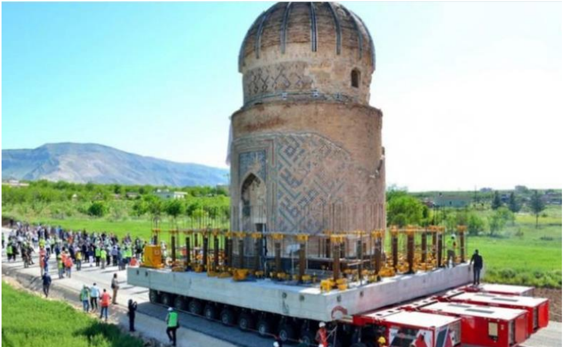
Şekil 19. Zeynel Bey türbesi taşınma esnasındaki görüntüsü (URL-21).
