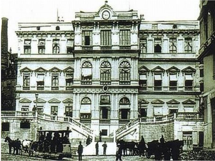
Şekil 3. Altıncı Daire-i Belediye Binası (Düzenleyen: OĞUZ.B).
