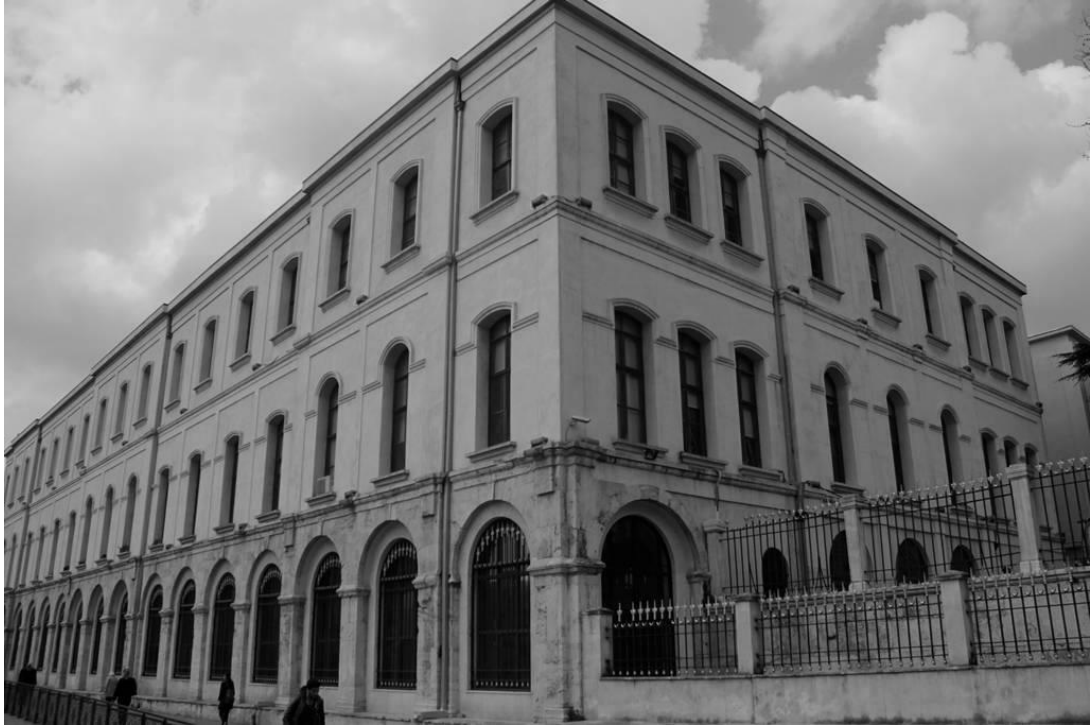
Şekil 1.5. Keçecizade Mehmet Paşa Konağı (Url-2)
