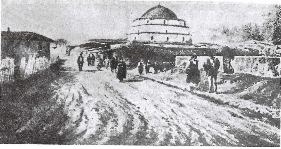
Sofya'daki Sofu Mehmed Paşa Camii'nin minareleri yıkıldıktan sonraki hali
