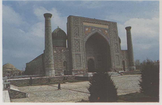
26. Semerkand: Şirdar Medresesi. Onarımdan sonra. (Yavuz)
