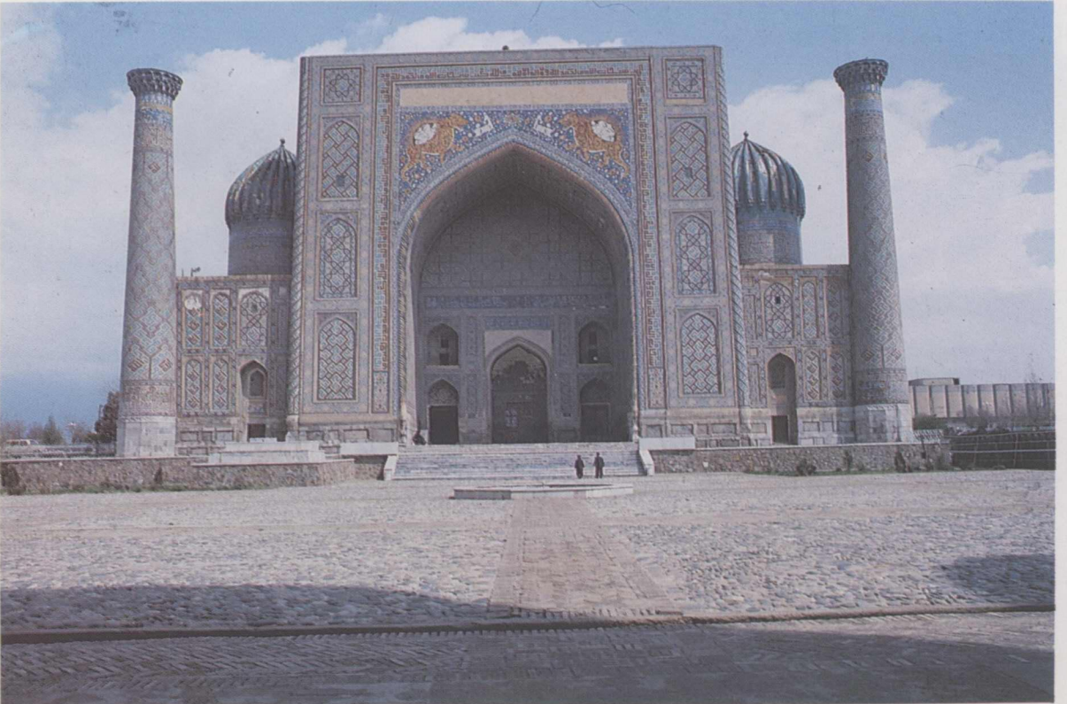
24. Semerkand: Şirdar Medresesi. Onarımdan sonra. (Yavuz)
