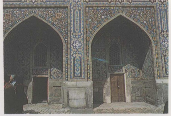
40. Semerkand: Tilyakari Medresesi. Onarım sonrası avludan ayrıntı. (Yavuz)
