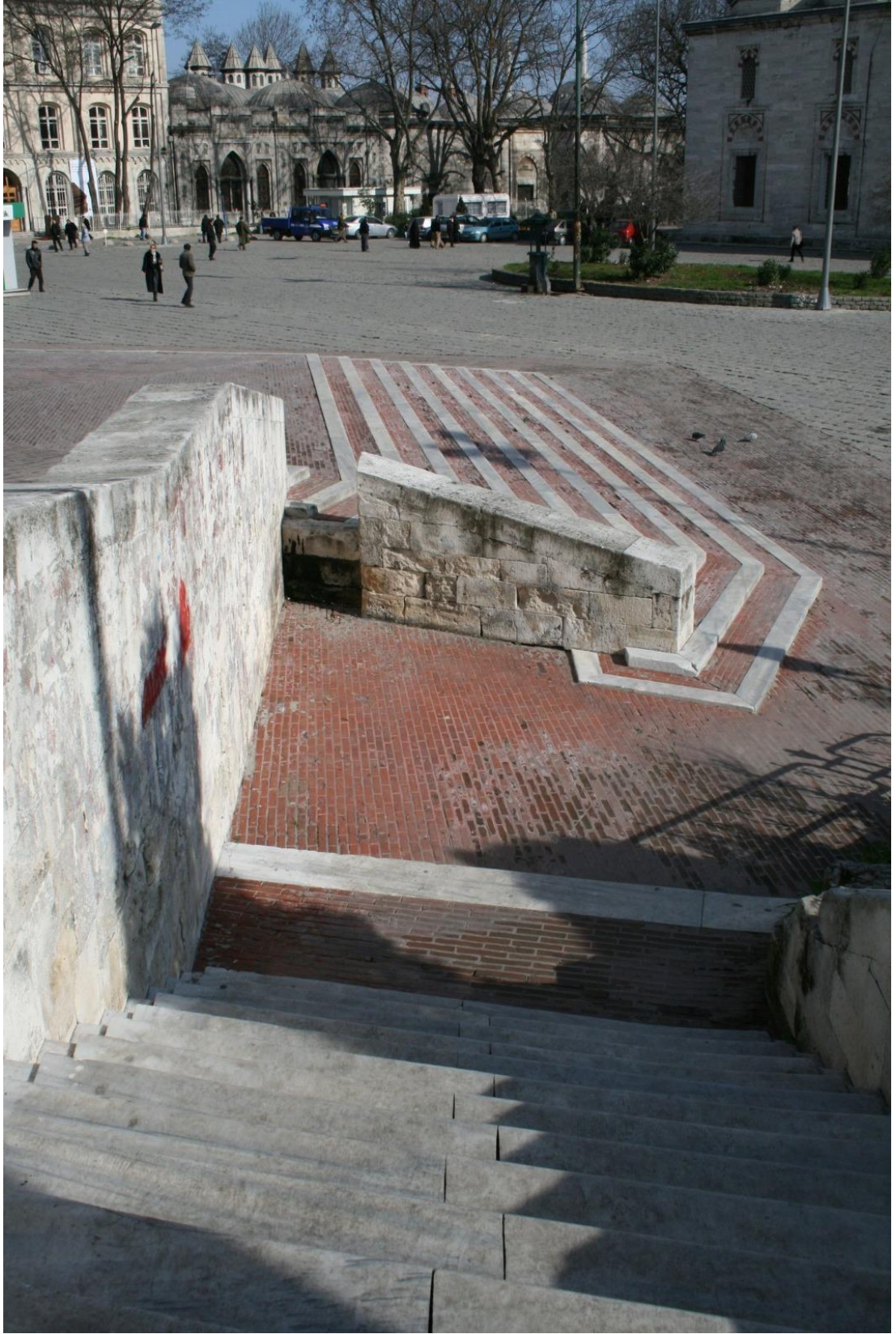
Aykut Köksal Fotoğrafları: 2014 yıkımından sonra tekrar inşa edilen merdivenler. (Ögün&Ögün Arşivi)
