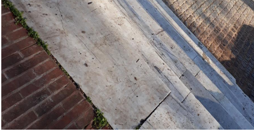
Şekil 2. 20 Zemin tuğla kaplama, masif mermer basamaklar ve granit kaplamanın beraber görüldüğü fotoğraf.
