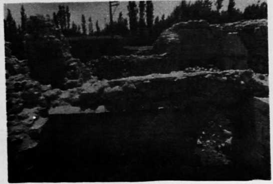
Resim 14 : Hani, Medrese, kuzeydoğu mekân, üstten görünüş
