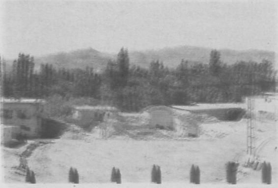
Resim 1 : Hani, Medrese, kuzeyden genel görünüş
