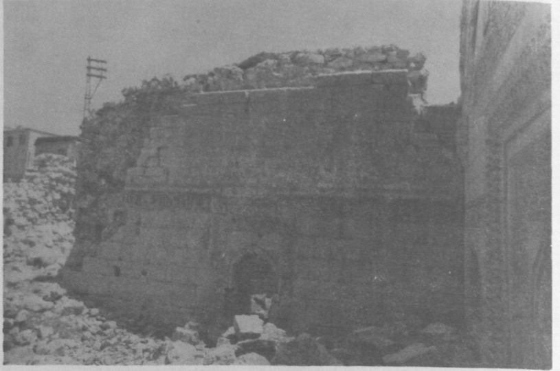
Resim 27 : Hani, Medrese, ana eyvan, doğu duvar
