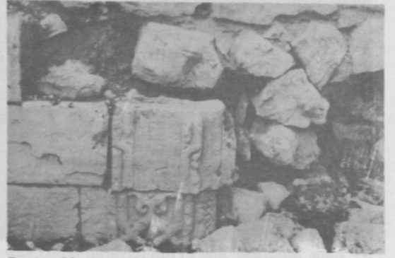
Resim 32 : Hani, Medrese, güneydoğu mekân, güney duvarın orta bölümünden ayrıntı (V.G.M. Arşivinden)
