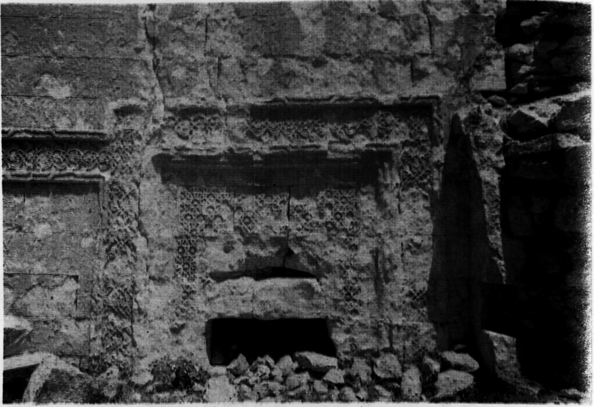
Resim 10 : Hani, Medrese, güney cephe, batıdaki ana eyvan penceresi
