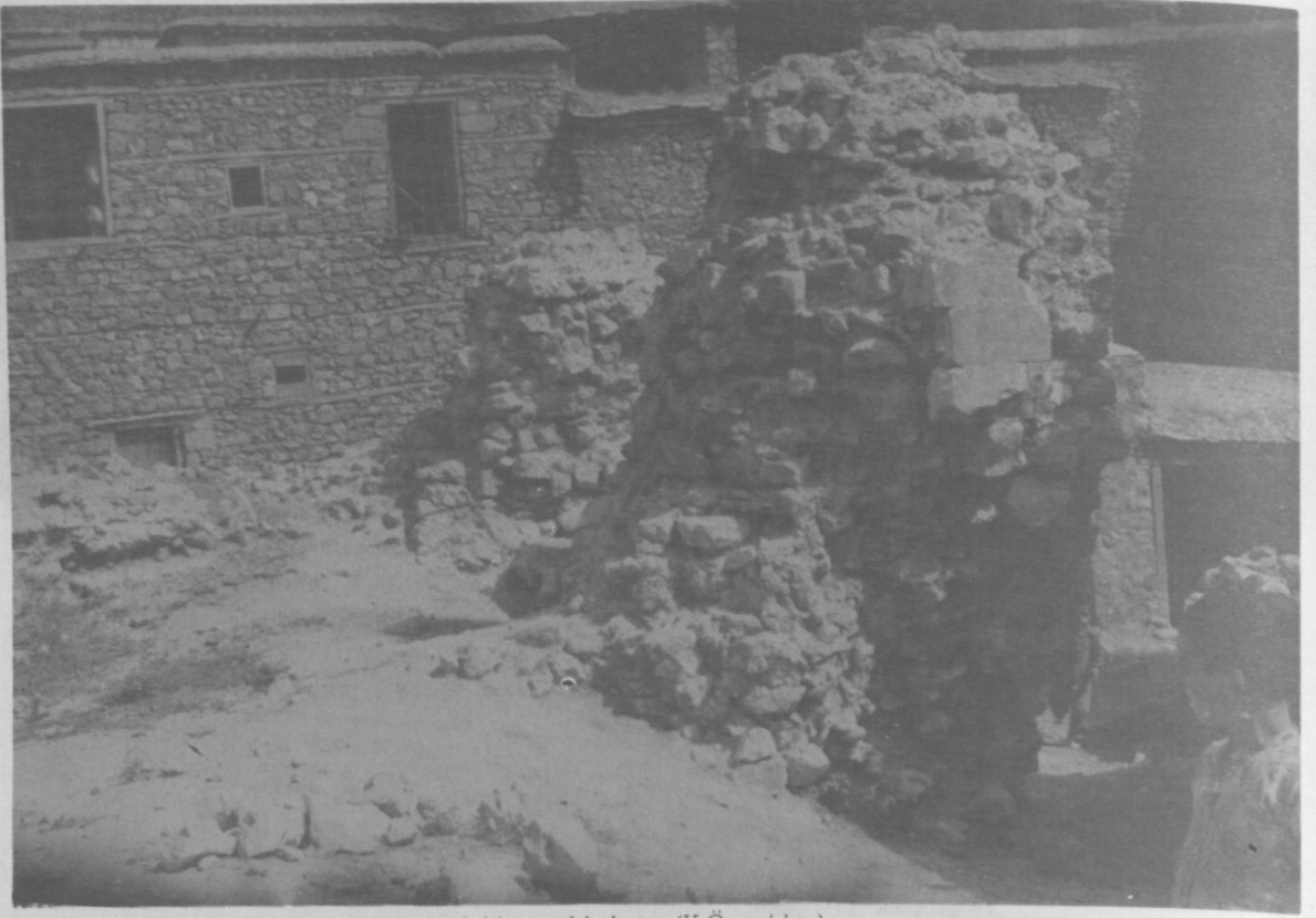
Resim 2 : Hani, Medrese, doğu cephedeki portal kalıntısı (Y.Önge'den)
