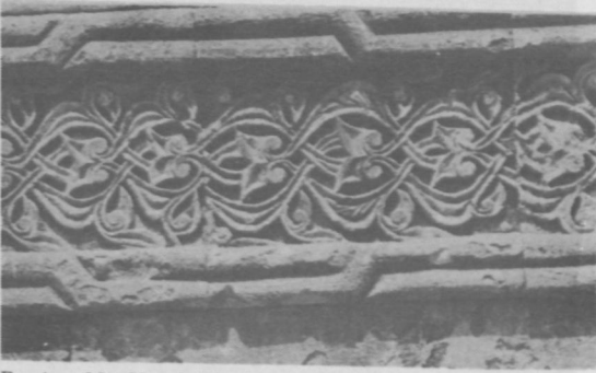
Resim 33 : Hani, Medrese, güney cephedeki rûmî-palmet bordüründen ayrıntı
