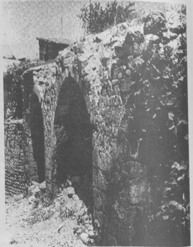
Resim : 22 — Maraş İkime Hatun Mescid - Türbe Kompleksi/Dış görünüm, (Onarım öncesi, 1966).
