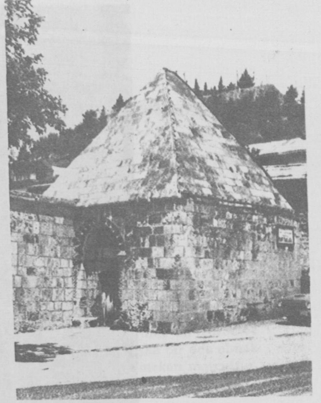
Resim : 30 — Maraş Taş Medrese Türbesi.
