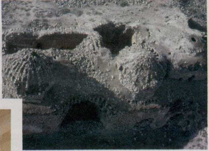
Resim-19 Hasankeyf Sultan Süleyman Camii minarenden üst örtü görünüşü
