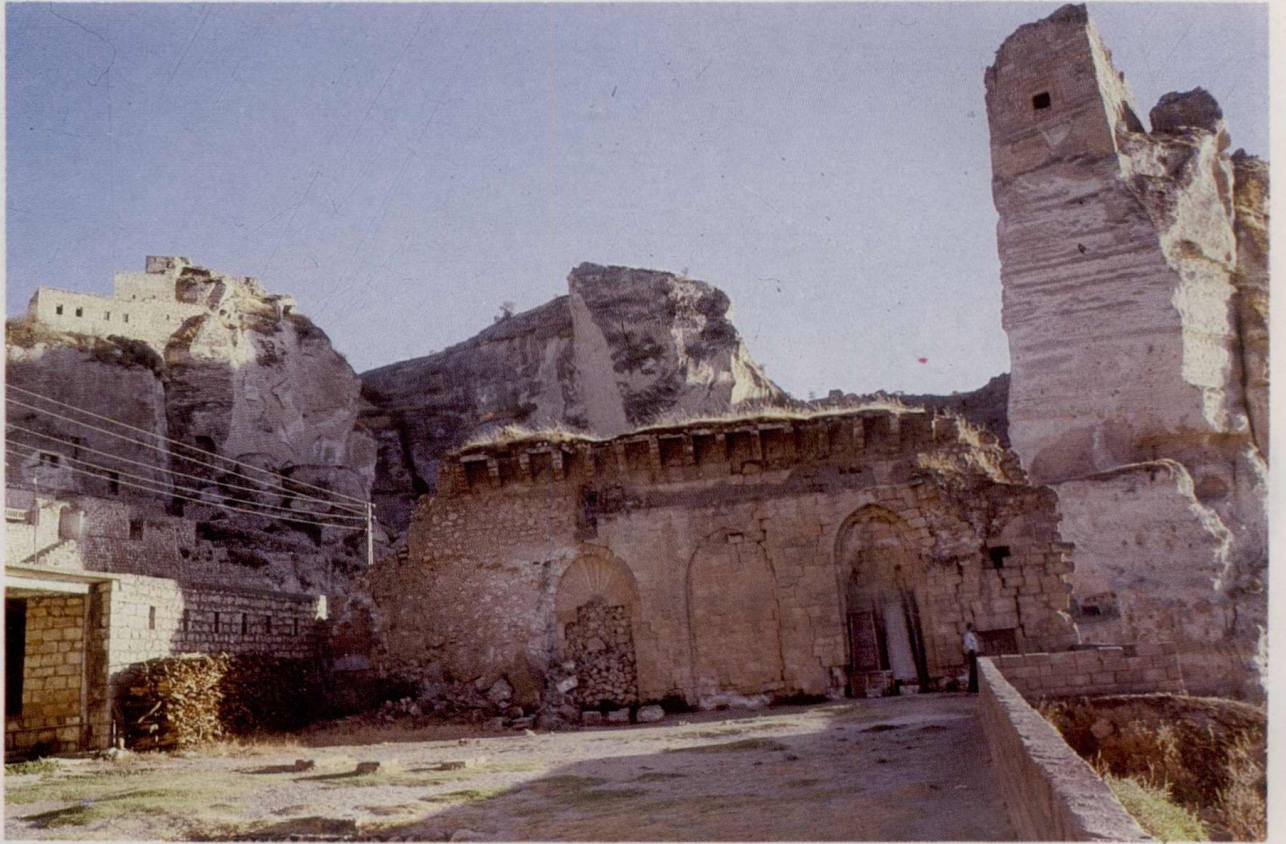
Resim-5 Hasankeyf Rızk Camii'nin yıkık harimi kuzey cephesi (Geride Küçük Saray)
