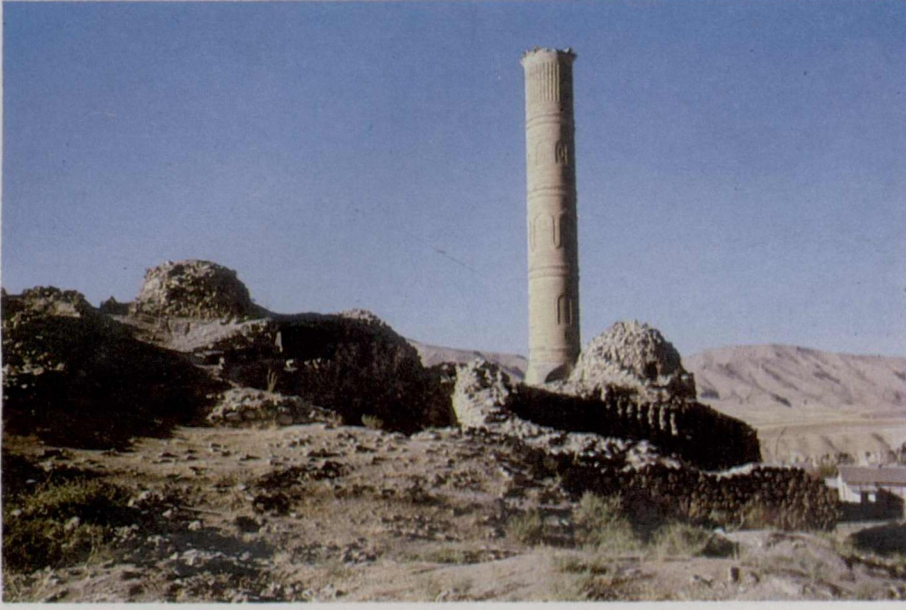
Resim-18 Hasankeyf Sultan Süleyman Camii güney cephesi
