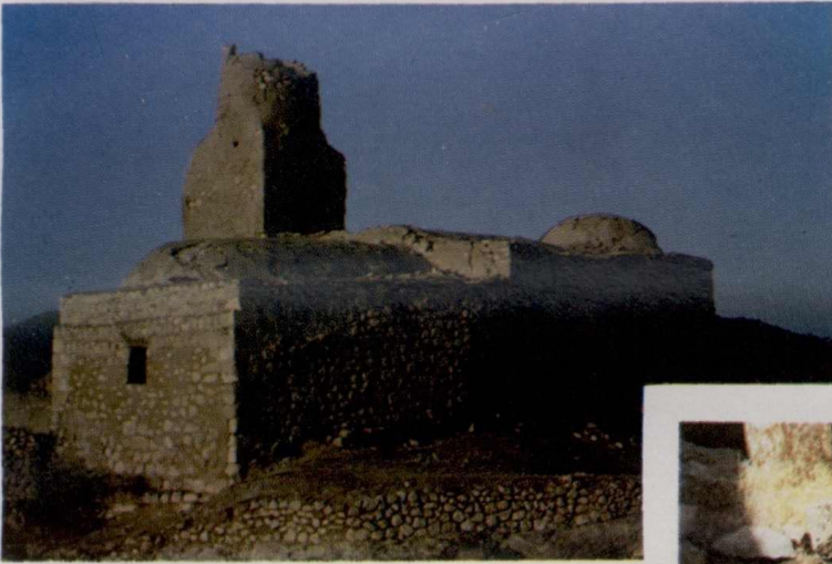
Resim-10 Hasankeyf Kale (Ulu) Camii Güney Cephesi
