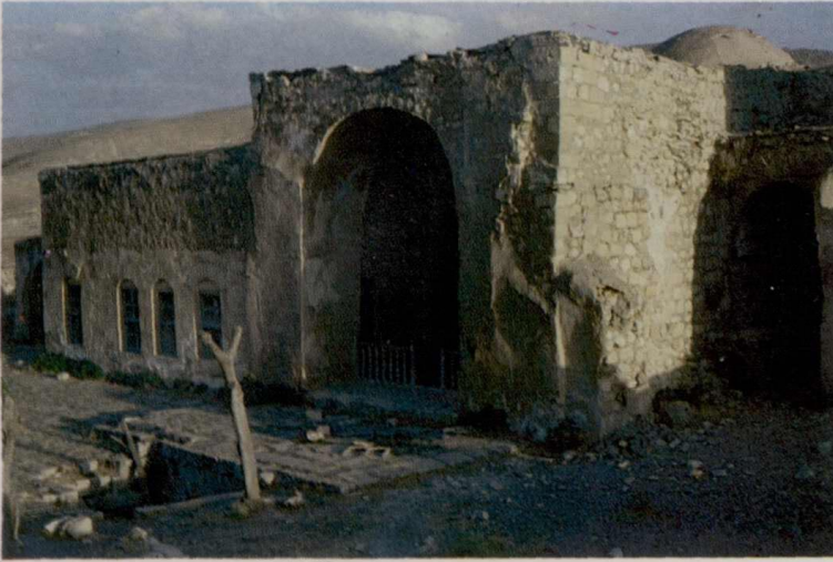
Resim-9 Hasankeyf Kale (ulu) Camii Kuzey Cephesi
