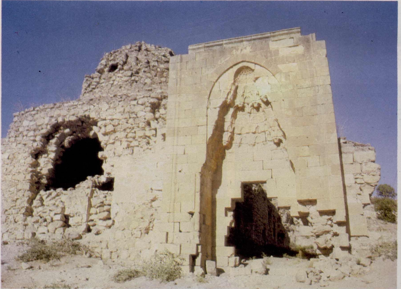
Resim-17 Hasankeyf Sultan Süleyman Camii çeşme ve Sultan Süleyman Türbesi
