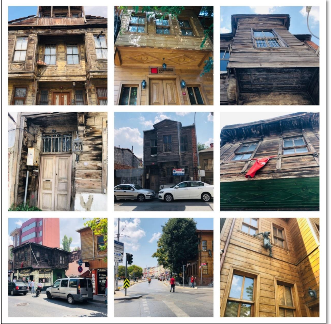
Şekil 40 Hasanpaşa Mahallesi kentsel imaj öğeleri
