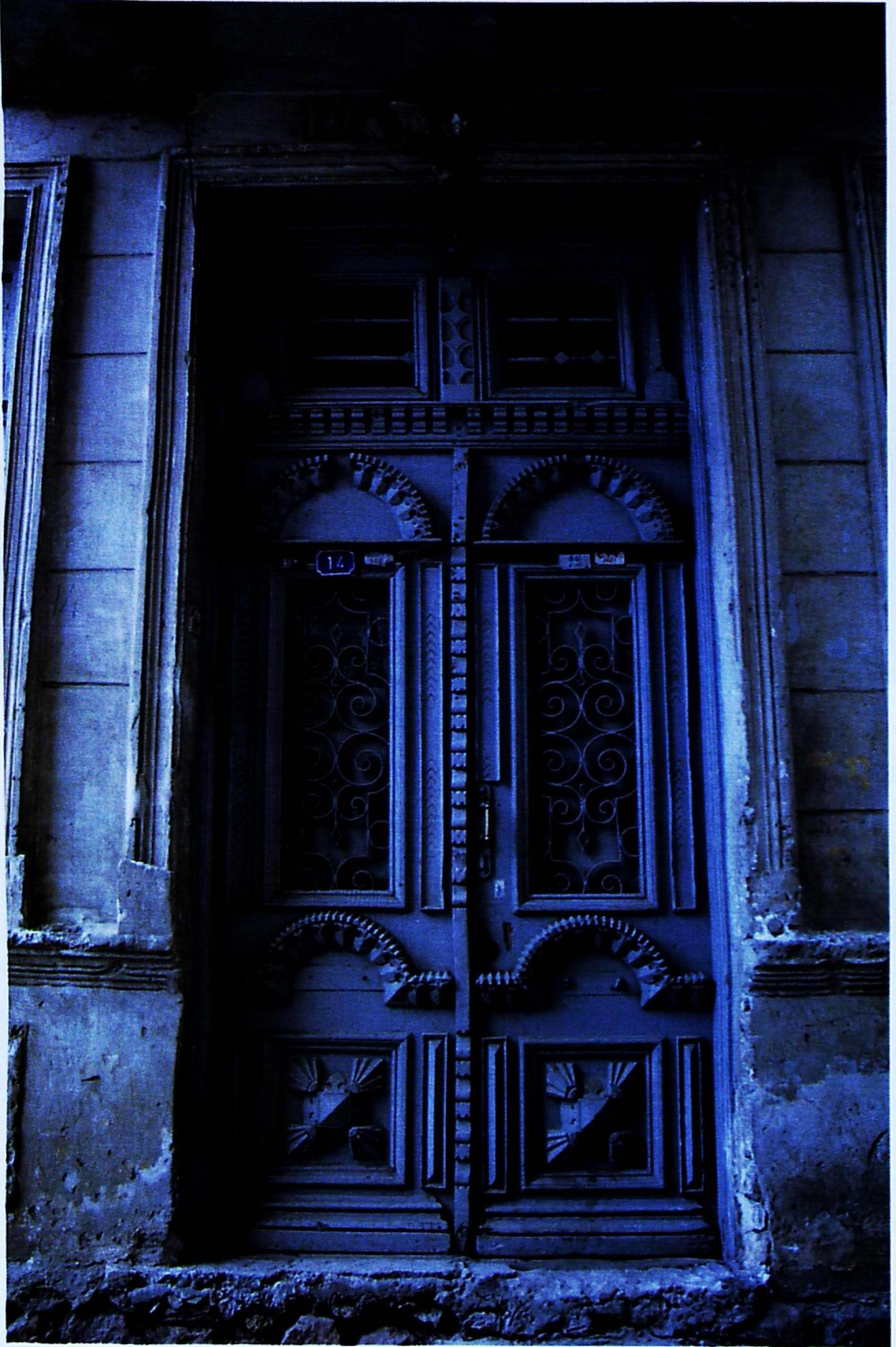
Fot. 30- Eski Tekel Binası Kapısı
