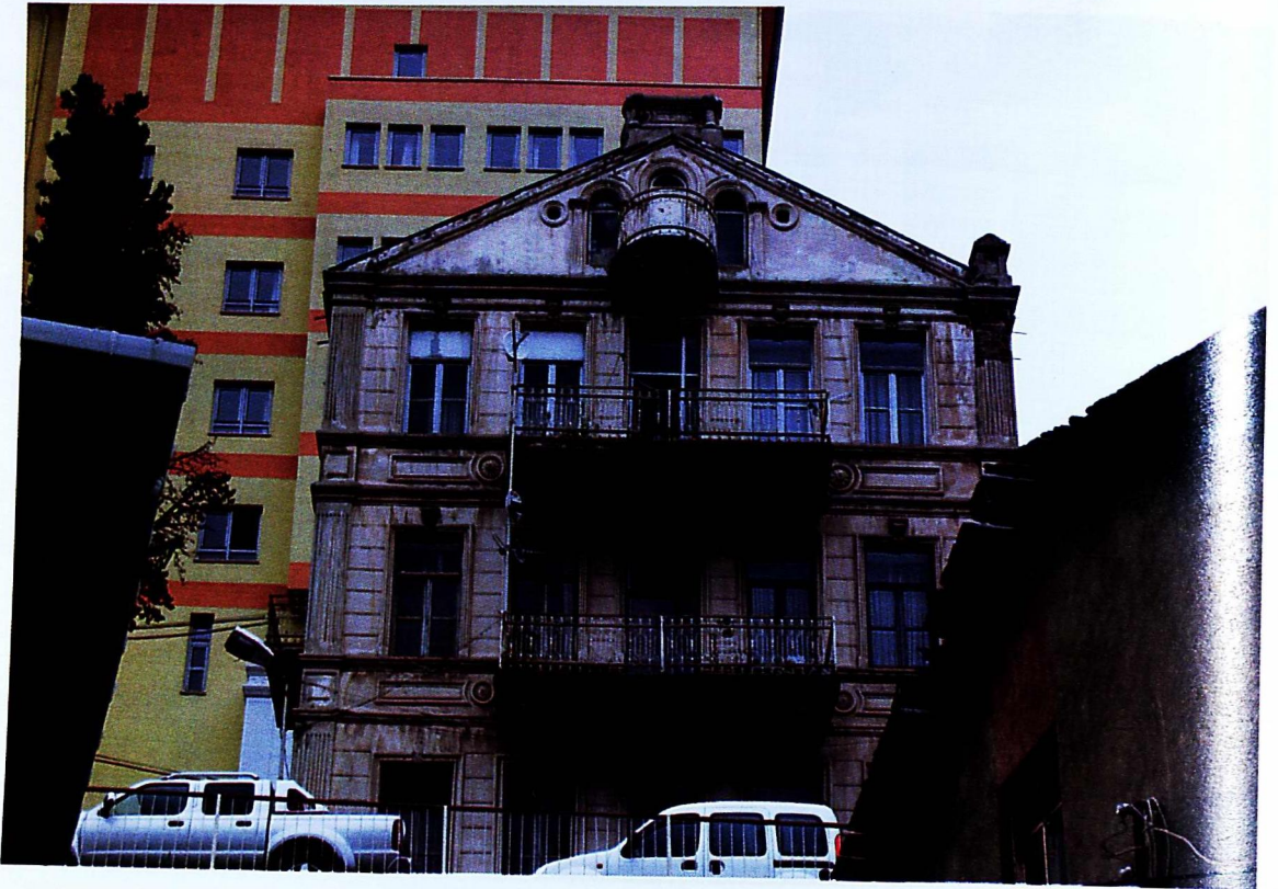
Fot. 4- Artvin İl Sağlık Müdürlüğü Binası
