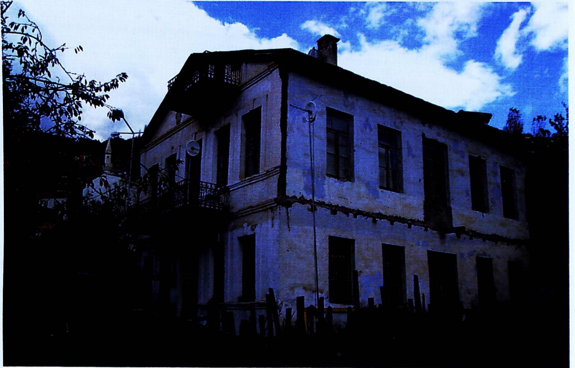
Fot. 28- Vahap İrmiş ve Ailesi Evi, Artvin
