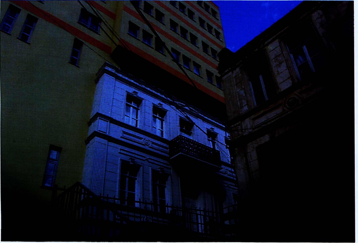
Fot. 37- İl sağlık müdürlüğü olarak kullanılarak yaşatılan tarihi bir Artvin yapısı ve yıkılarak Devlet Hastenesi strüktürü içinde sadece bir cephe imitasyonu ile yaşatılan bir başka tarihi Artvin yapısı ya da bir korumacılık ironisi!
