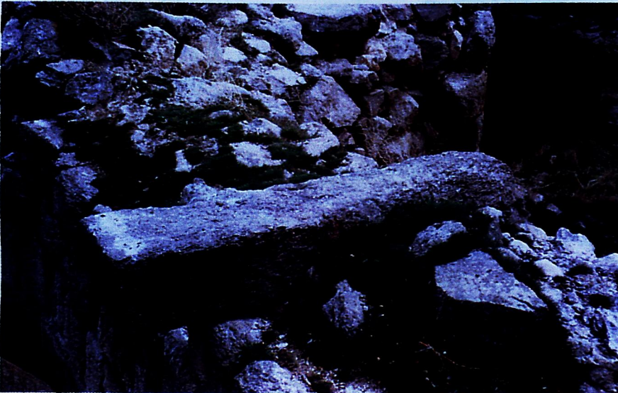
Resim 28: Pertek Kalesi giri kapısı üstündeki konsol parçası.
