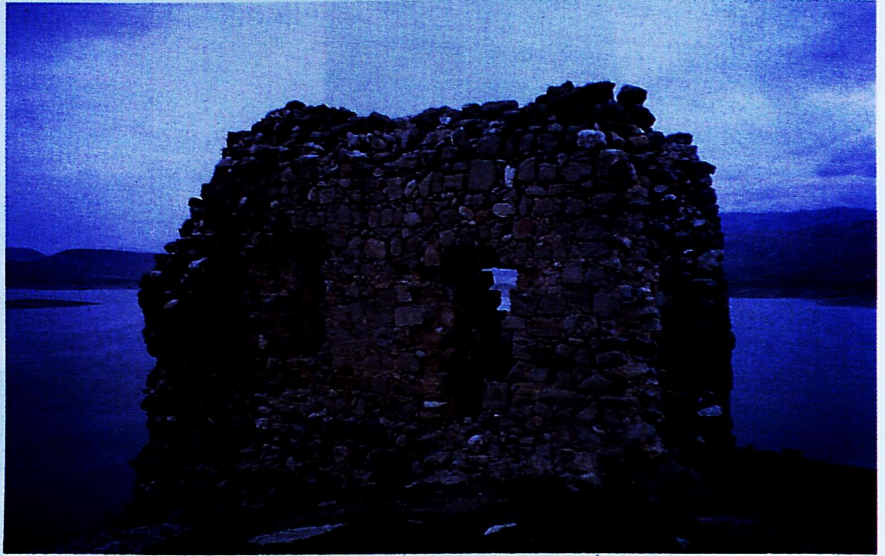
Resim 27: Pertek Kalesi kuzeybatı burç.
