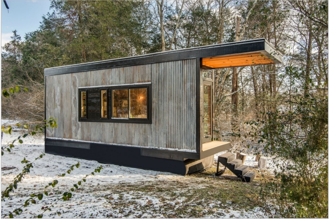
Şekil 3. 11: Taşıyıcıları ve kaplamaları dönüştürülmüş ahşaptan oluşan mobil yapı (Jewell, 2018).
