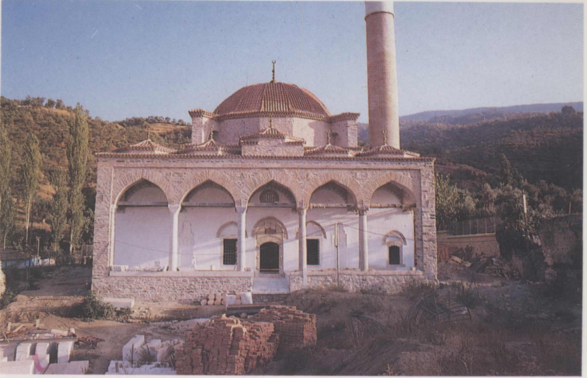
2. Caminin ön cephesinin onarım sonrası durumu.
