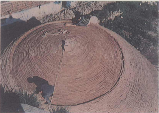
7. Kubbenin onarım esnasındaki durumu.
