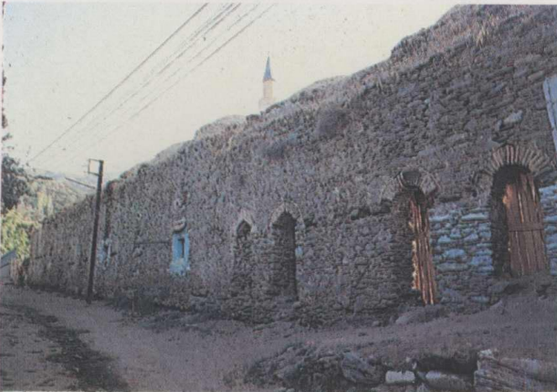
18. Aşevinin arka cepheden görünüşü.
