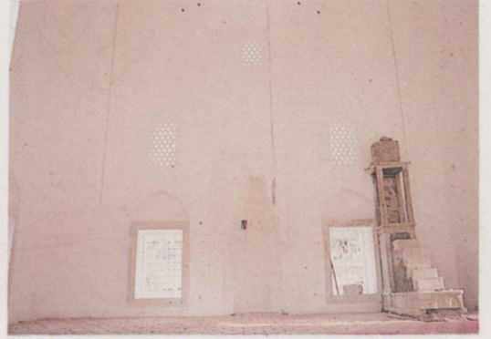
9. Mihrap ve minberin onarımdan sonraki durumu.
