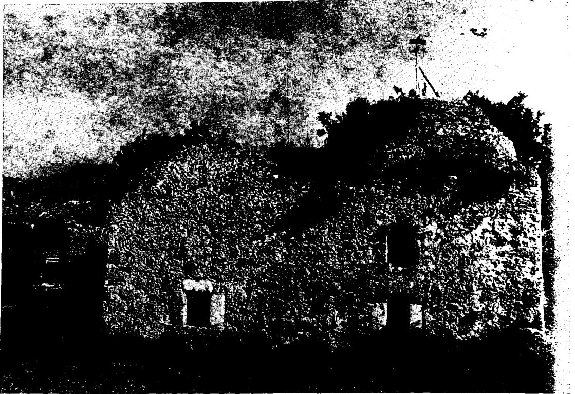
Res. 18 — Oba Köyü Medresesi. Binanın güney cephesi.
