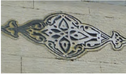
e- Güneybatı cephesi
