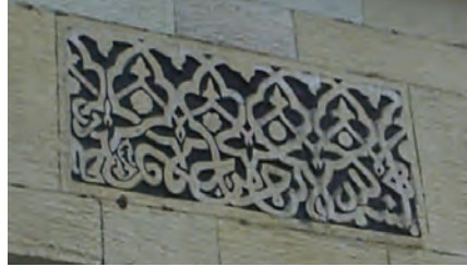
d- Batı cephesi
