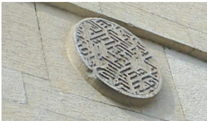
i- Doğu cephesi
