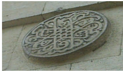
h- Kuzeydoğu cephesi
