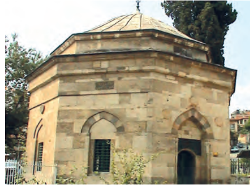
b- Kuzeydoğu Cephesi [Fot: İsmet Çalık]
