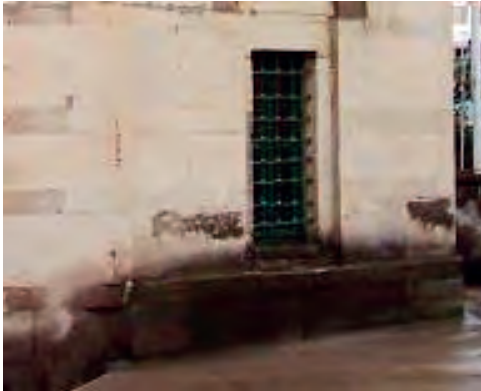
c- Batı cephesi
