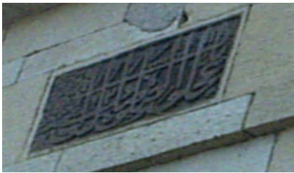
g- Kuzey cephesi
