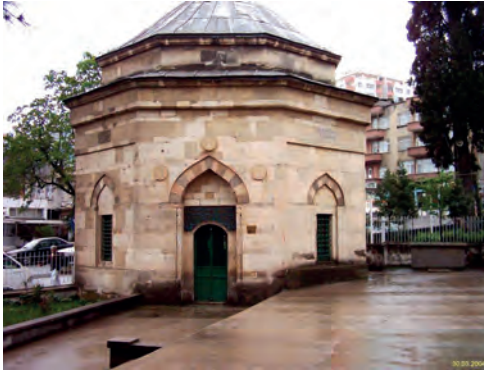
a- Kuzey Cephesi
