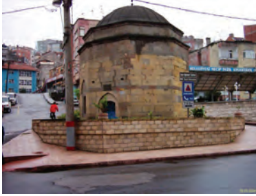
a- Kuzey Cephesi
