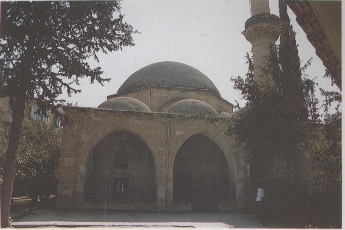
16. K.K.T.C. Lefkoşa Arap Ahmet Camii, kuzey cephe görünüşü.
