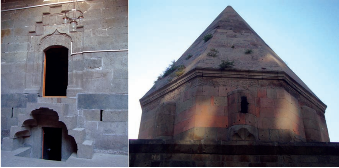
Fotoğraf 1. Gevher Nesibe Türbesi, alt- üst kat giriş kapıları ve dıştan külahı bakış.
