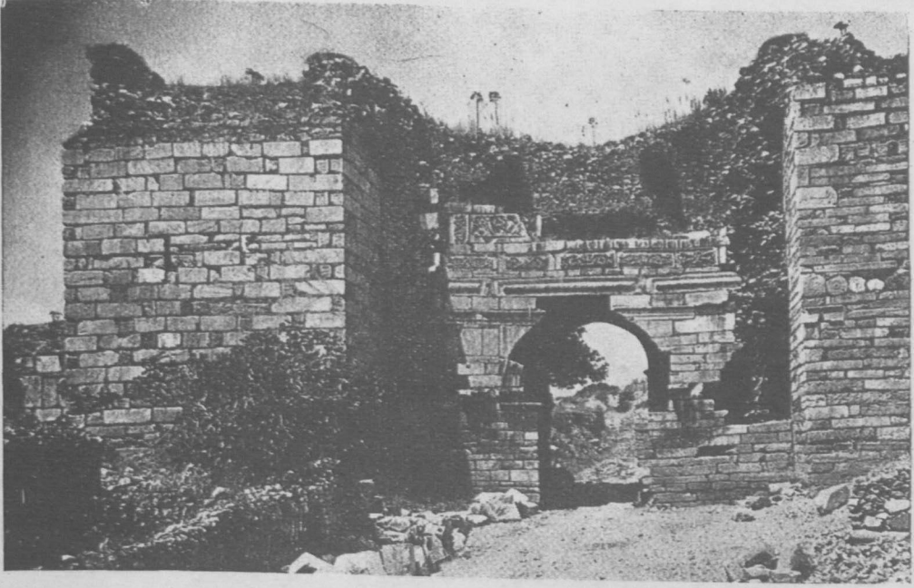
Res. 1 — Efes Ayasluđ hisarının dıř kapısı.
