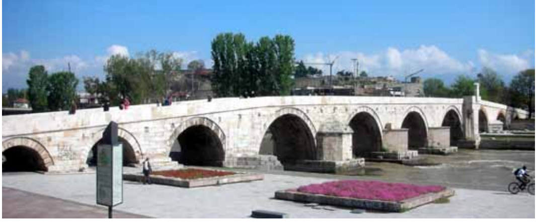
Üsküp Fatih Sultan Mehmet Köprüsü (2009)
