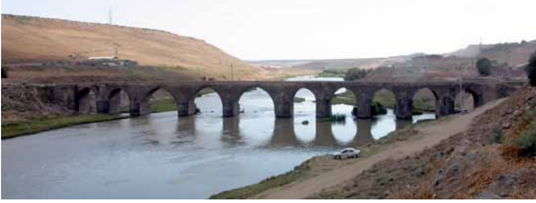
Diyarbakir Dicle Köprüsü
