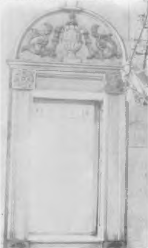
RESİM : 40 Nusretiye Camii pencere aynılığı.
