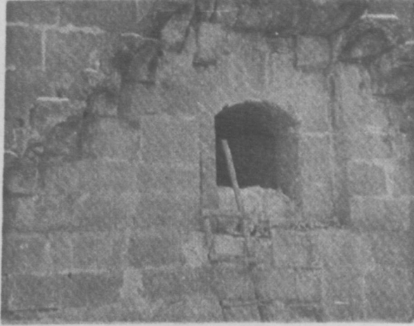
Resim : 20 — Darülhadisin Kuzey cephesindeki mezar odasının girişi.
