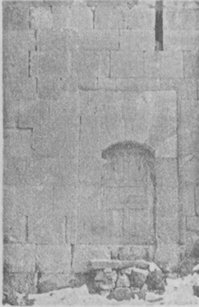
Resim : 13 — Darü'lhadis'in doğu cephesindeki kapısı.
