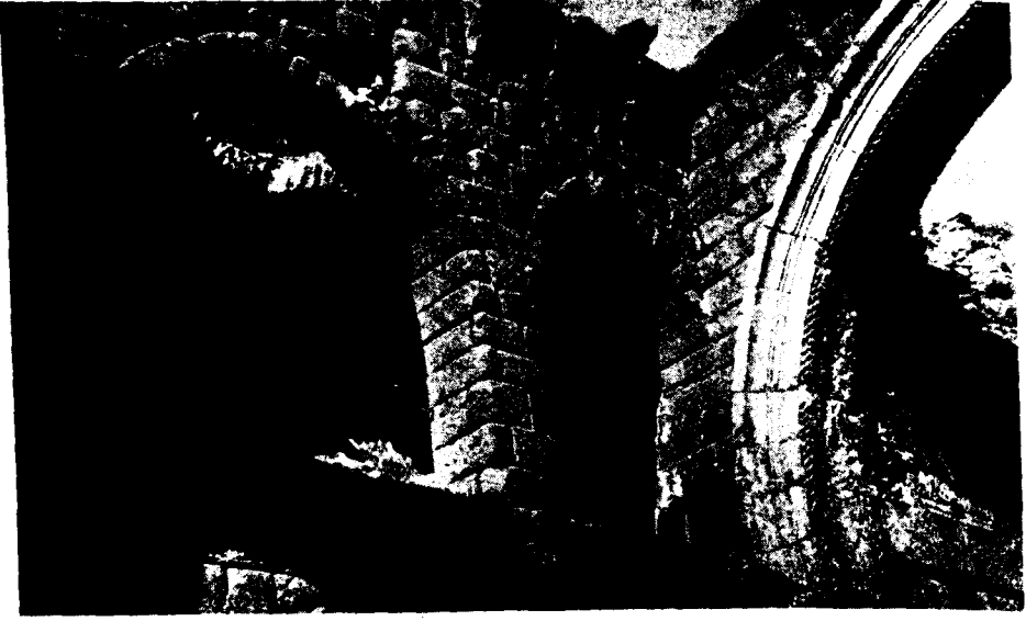
Res. 43 — Diyarbakır Ulu Camii mimari manzumesinden Mesudiye Medresesi baş eyvan ve üst kat kemerleri kuzey tarafı
