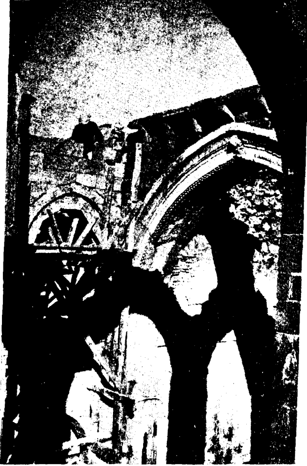
Res. 42 — Diyarbakır Ulu Camii mimari manzumesinden, Mesudiye medresesi baş eyvan kemerli
