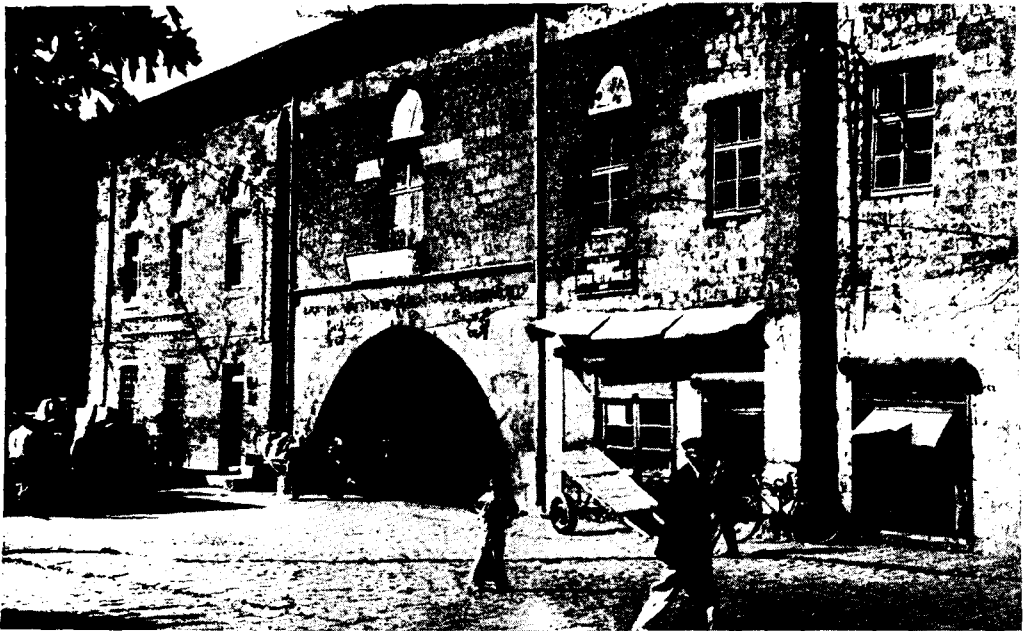
Res. 8 — Diyarbakir Ulu Camii çarşı yüzündeki esas giriş kısmı.
