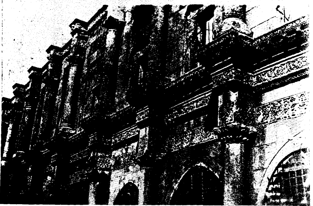
Res. 16 --- Diyarbakır Ulu Camii avlu kısmından doğu taraf maksureleri yüzü (Alt ve üst kolonlar, başlıklar ve ana silmeler).
