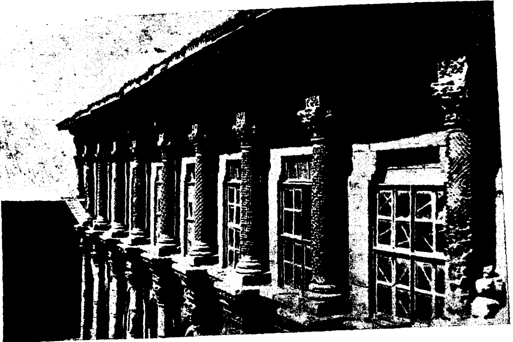
Res. 20 — Diyarbakır Ulu Camii avlusunun batı taraf makuresinin üst kısmı yüzü
