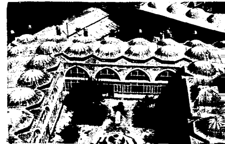
Manisa Muradiye Camii Külliyesi
