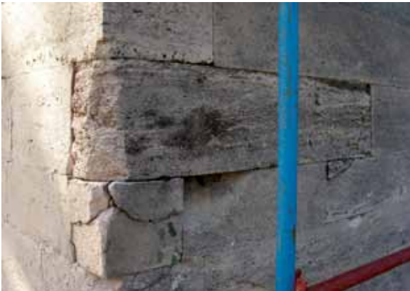
Fotoğraf 16. Kopmuş mevcut taş ile kayıp taşın boşluğu.
