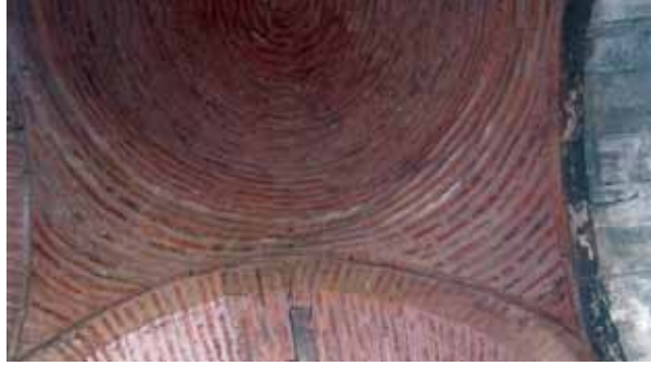
Fotoğraf 15. Revak kubbesinde temizlik için yapılan testlerin sonucu ile temizlik sonrasında tuğla kemer ve kubbelerin genel görünüşü.
