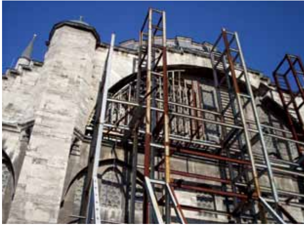
Fotoğraf 2. Caminin mihrap cephesinin onarım öncesi kemerden taş düşmüş hali ve onarım sonrası kemere taş konmuş halinin görünüşü.
