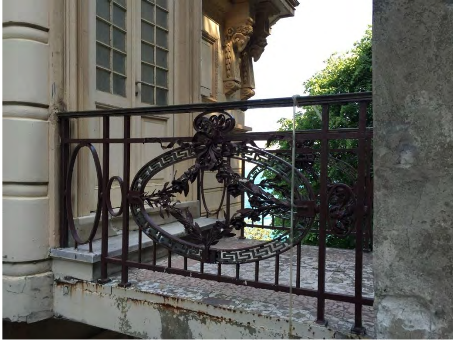
Resim 4.44 ıkma merdivenler trabzanları
