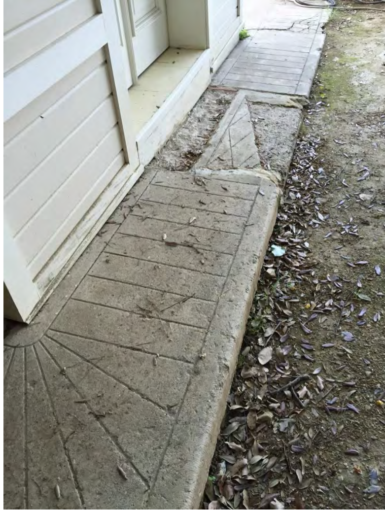
Resim 4.61 Set Köşkü İngiliz betonu orijinal kaldırımı
