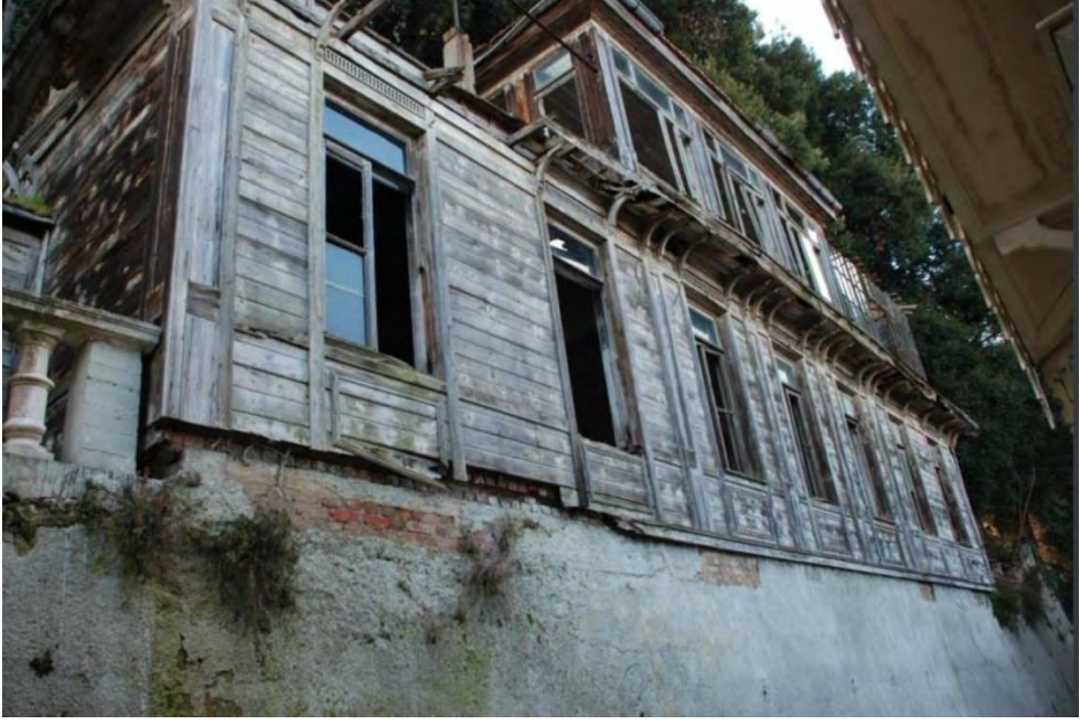
Resim 3.29 Set Köřkü Restorasyon öncesi
