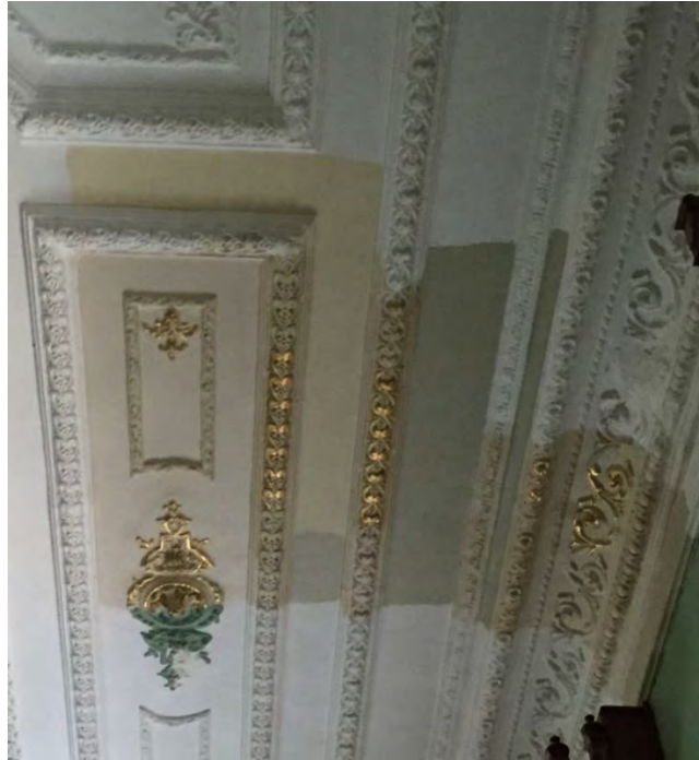
Resim 4.60 Huber K şk  altın varak kartonpiyer s slemeleri
