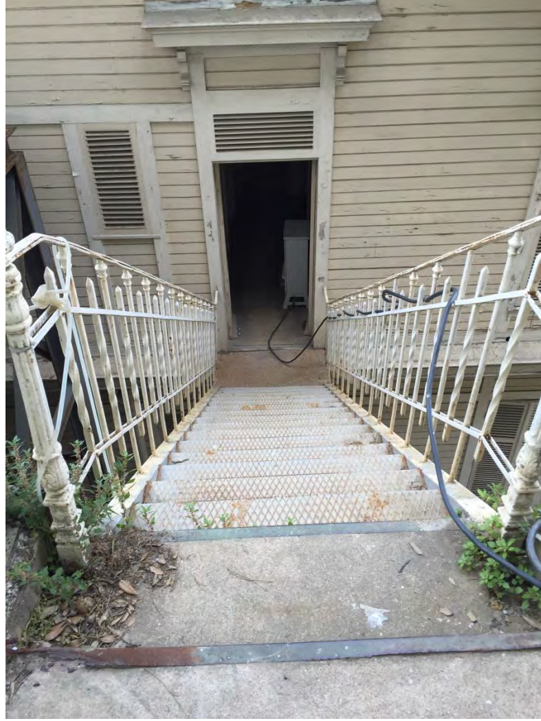
Resim 4.69 Faytonhane ve Set Köşkü arasındaki merdiven
