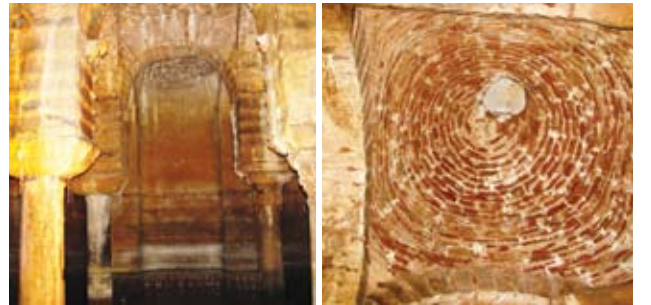
Büyük sarnıç adını verdiğimiz (Bonos Sarnıcı I) ve caminin avlusunun altına doğru giden sarnıç; solda dorik, sağda korent düzeninde sütun başlıkları. Orta nef güneydoğu uçta kavislidir. Tonoz içinden tuğla işçiliği.
