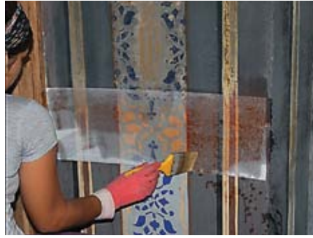
Kalemişi yüzeylerde yapılan kimyasal temizlik
