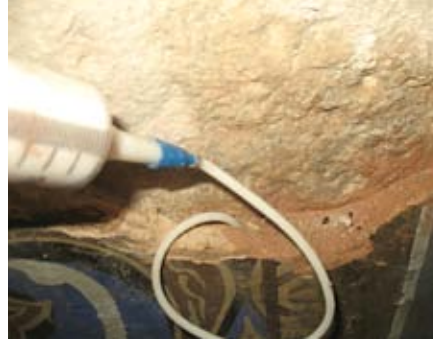
Sıva arkası enjeksiyon yapılması
