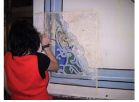
Kalemişi yüzeylerde mekanik raspa
