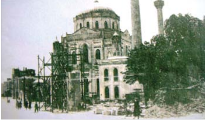
Bahçe duvarları ve taç kapının yerinin değiştirilmesi
