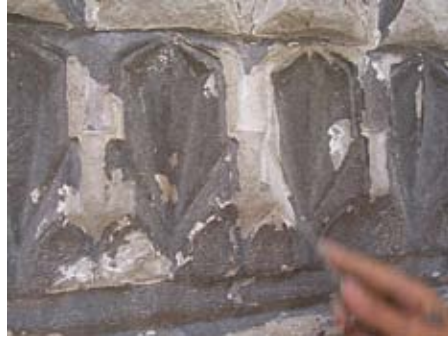
Taş yüzeylerde mekanik temizlik
