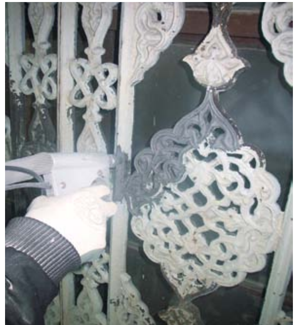
Taş yüzeylerde mekanik temizlik
