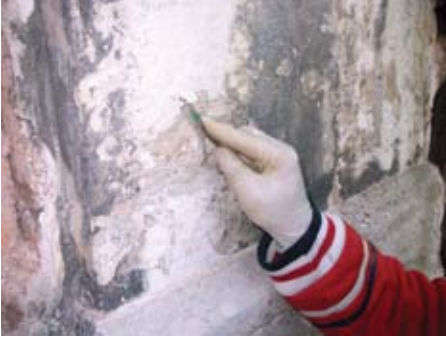
Taş yüzeylerde mekanik temizlik
