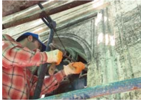
Çimentolu niteliksiz onarımların uzaklaştırılması
