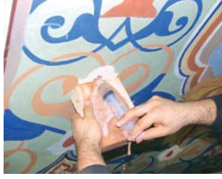
Yuvanın temizlenmesi
