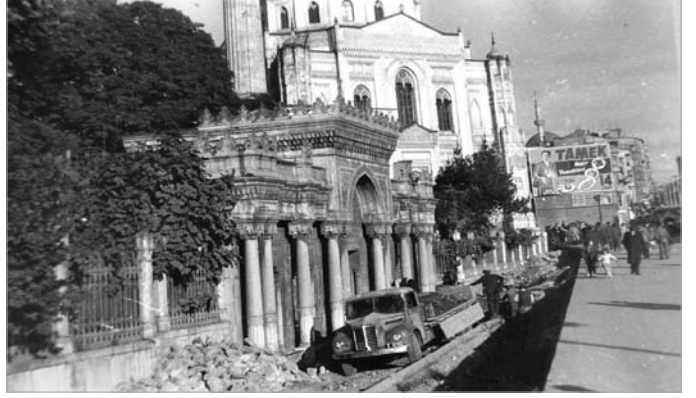
Yer altı çarşısının inşaat çalışmaları (V.İ.B.M.A.)
