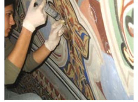
Sıva duvar arası enjeksiyon yapılması
