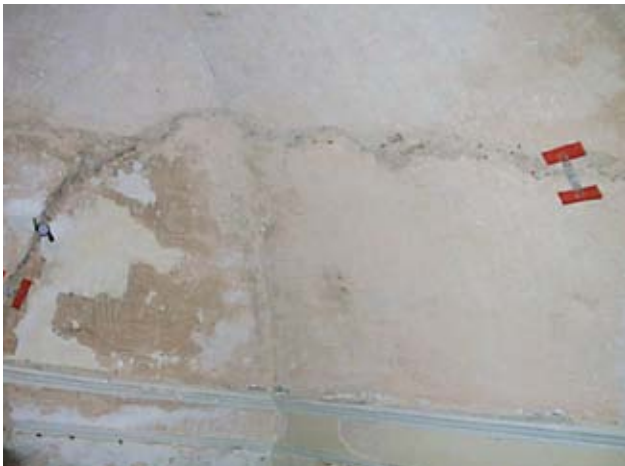
Yerleştirilen çatlak ölçüm aletleri
