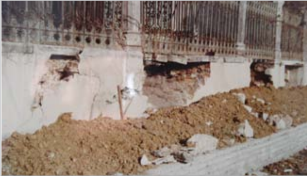
Bahçe duvarlarında yapılan onarımlar (V.İ.B.M.A.)
