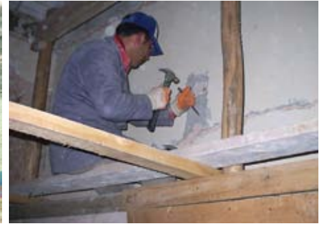
Çimentolu niteliksiz onarımların uzaklaştırılması
