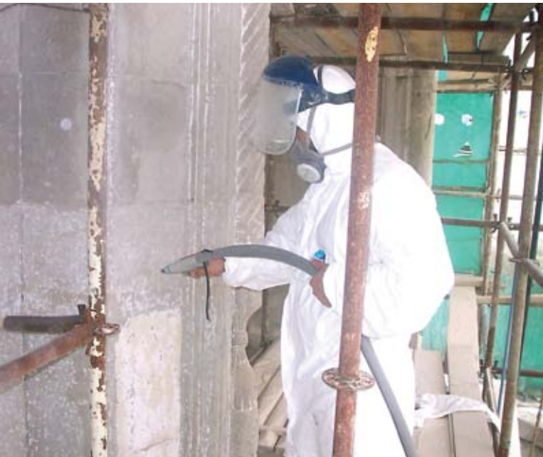
Taş yüzeylerde mekanik temizlik
