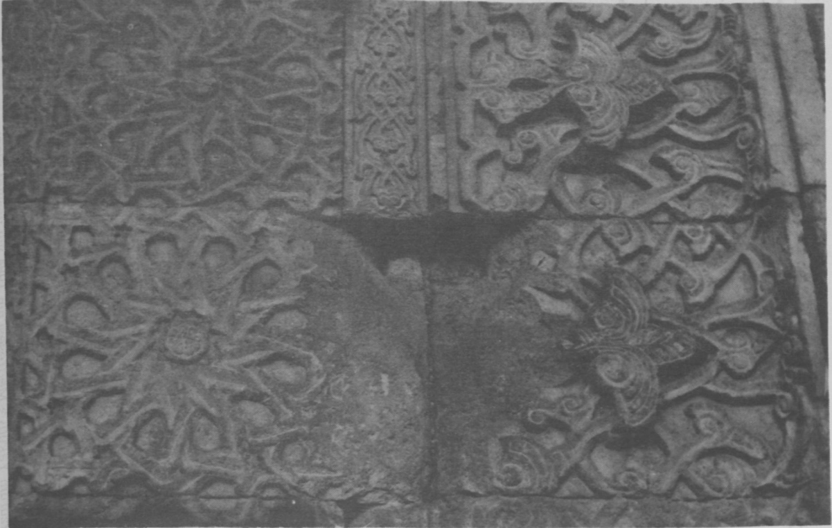
Resim 23 : Portal taşlarındaki perçin
