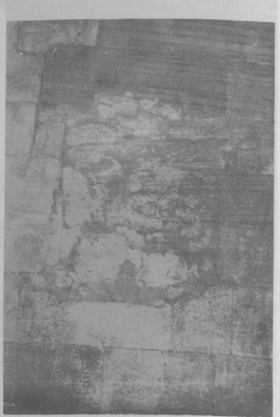
Resim 9 : Batıdaki eyvanın gney duvarında bulunan dolap nii.
