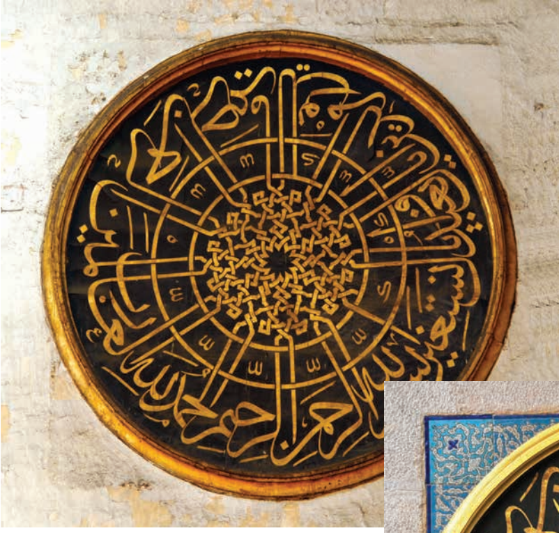
Fotoğraf 8. Restorasyon öncesinde sıvalı yüzey
