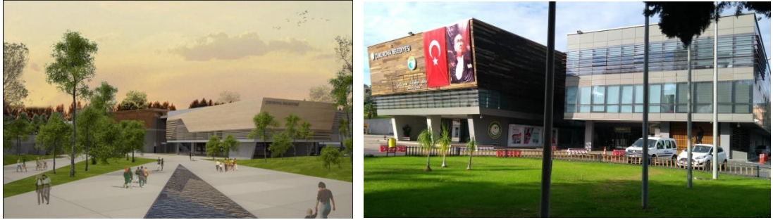
Resim 4.9 Çukurova Hizmet Binası ve Kültür Merkezi tasarımı (URL-18) ve uygulanmış bina (yazar tarafından)
