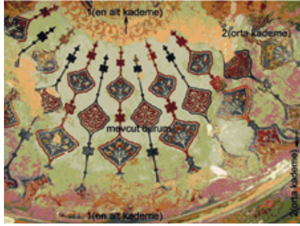
Fotoğraf 2 Çamii Hünkar girişi ve doğu girişi kubbelerinde raspa ile açığa çıkarılmış olan dönemsel tabakalar.
