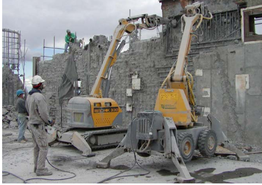
Resim 2.9 Şantiyede robotik üretim. (Url-13)
