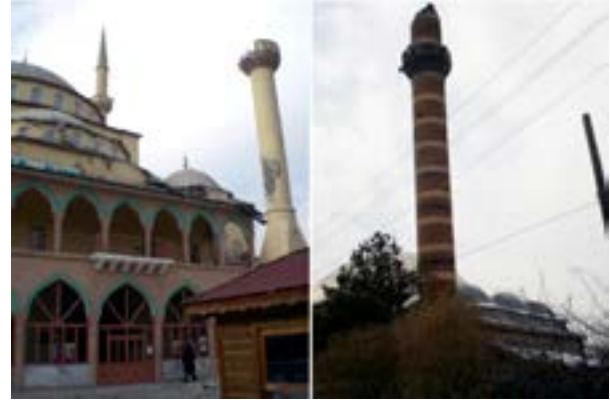
Şekil 2. 23 Ekim 2011 Van depreminde oluşan minare hasarı örnekleri
