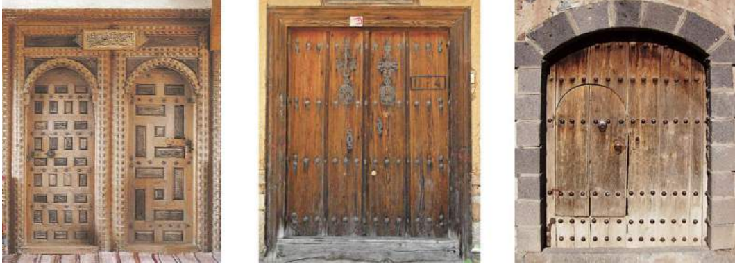
Resim 1. Geleneksel Türk Evi’nde oda kapısı, dış kapı ve kuzulu kapı (Kuban, 1995; URL-3; URL-4)
