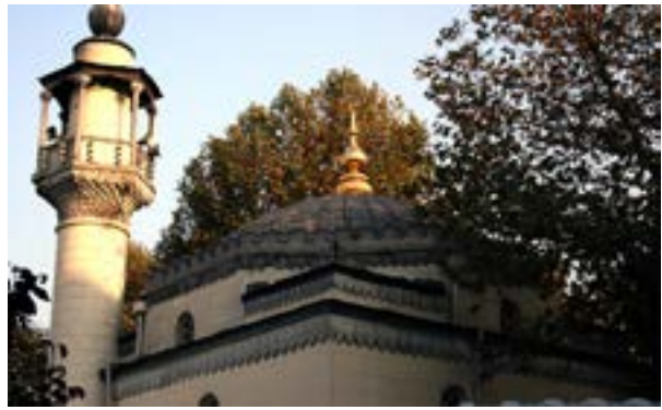
Fotoğraf 4. Minare ve üst örtü sistemi görünüm
