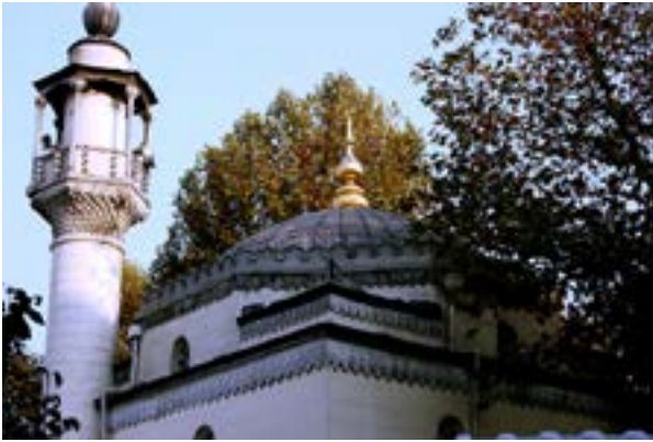
Fotograf 14. Kubbeye Geçiş Ögeleri ve Minare Görünüm
