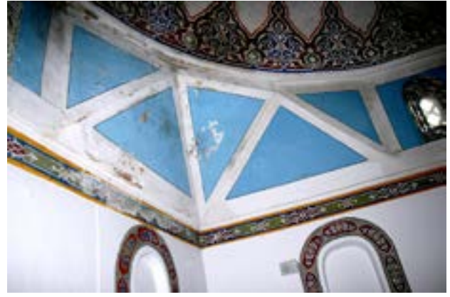
Fotograf 12-13. Kubbeye Geçişte Yer alan Revzenli Penceler ve Üzerlerinde Oluşan Bozulmalar
