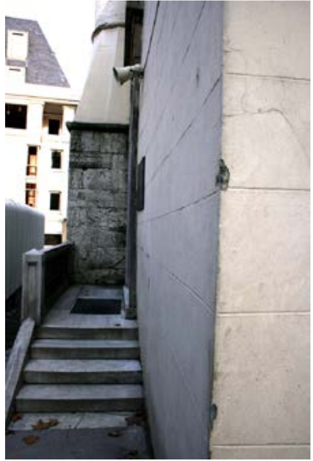
Fotoğraf 6. Ana Giriş Kapısı Merdivenleri
