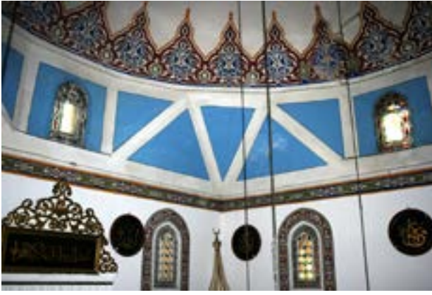
Fotograf 12-13. Kubbeye Geçişte Yer alan Revzenli Penceler ve Üzerlerinde Oluşan Bozulmalar
