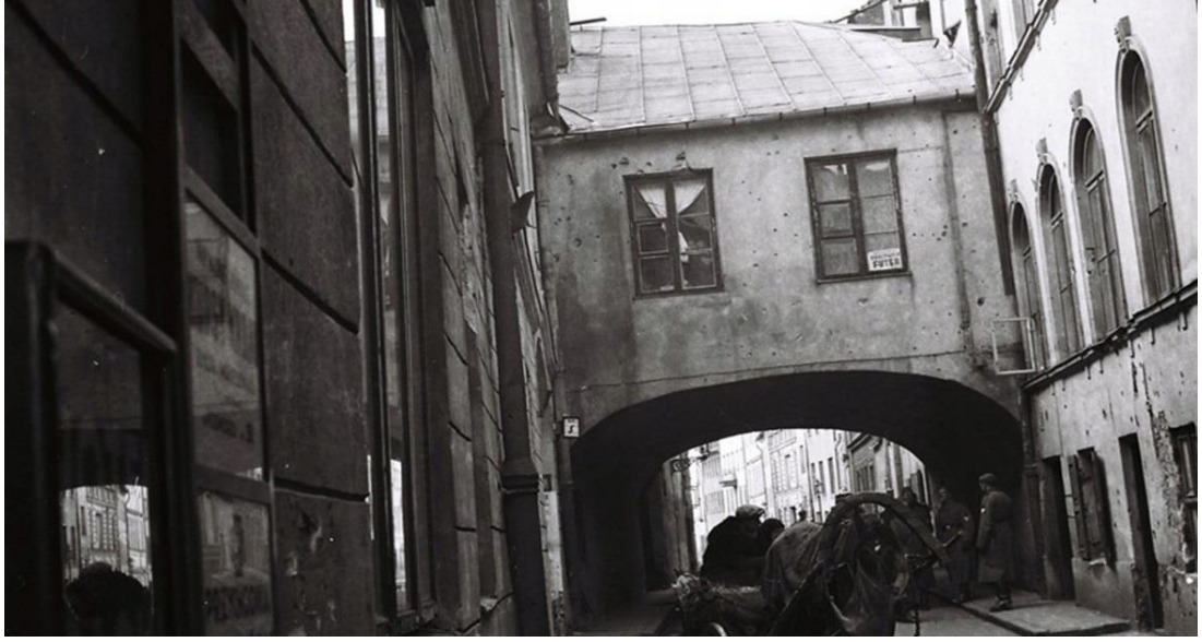
Şekil 2. 46: Mermilerin gerçek yeri ve çatının penceresiz hali (URL- 18)
