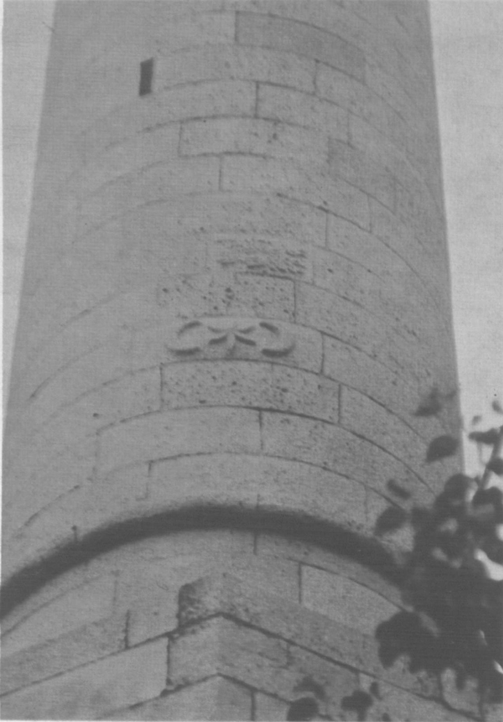
RESİM 16 : Krumovgrad Camisi minarede bulunan kitabe ve ayyıldız.
