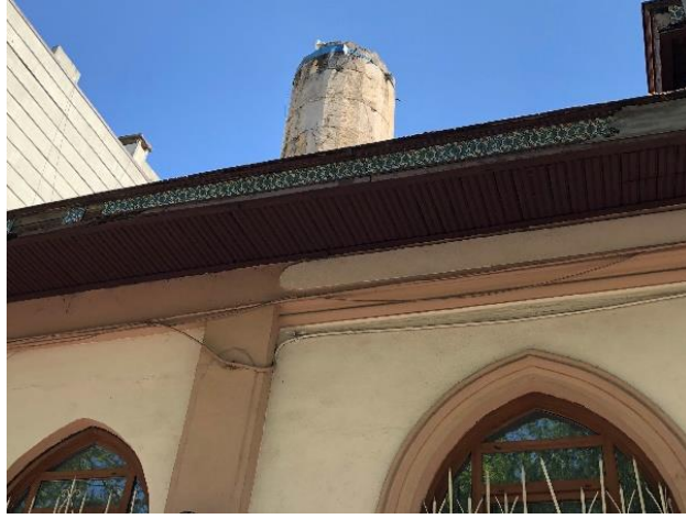
Şekil 2.7.1 Hüsambey Tezgahçılar Camii : Ön Cephe
