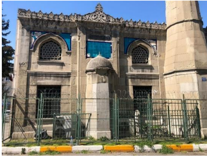
Şekil 2.3.2 Kamer Hatun Camii : Arka Cephe
