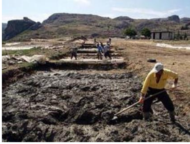
Şekil 1. 6: Kerpiç harcının karıştırılması [10].
