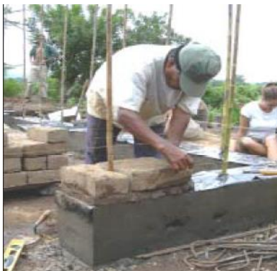
Şekil 1. 10:TS2515'e göre kerpiç duvar örgüsü [9].
