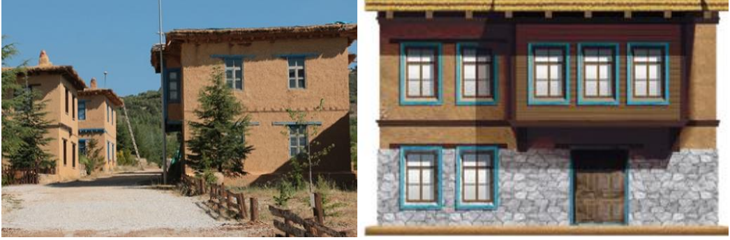
Şekil 2. 10: Sonsuz Şükran Köyü kerpiç evleri, Konya [19].
