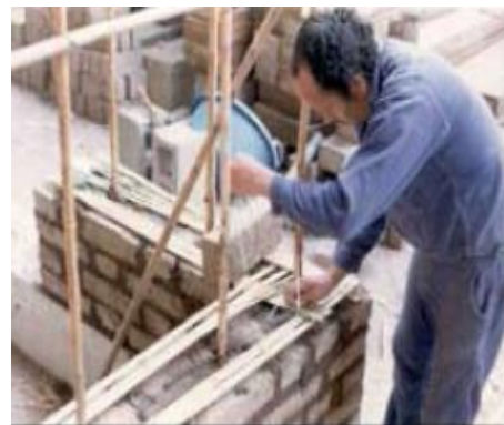
Şekil 1. 10:TS2515'e göre kerpiç duvar örgüsü [9].
