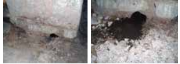
Fotoğraf 10-11. Paye altlarında ahşap hatil yuvaları ve toz halinde ahşap hatillar
