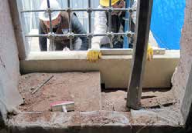
Fotoğraf 40-41. Pencere sövelerine etki eden ayrılmanın izlerinin onarımı
