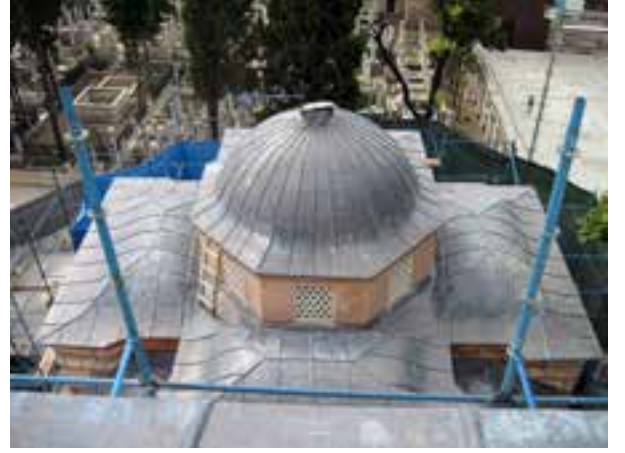
Fotoğraf 49. Kurşun örtü yenilenmesi
