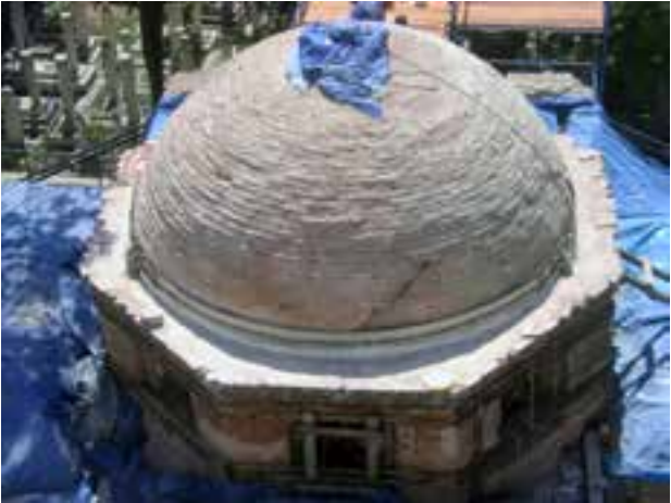
Fotoğraf 31-32. Merkezi kubbe eteğinde çemberleme sistemi
