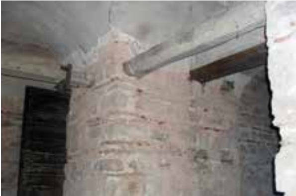
Fotoğraf 12. Bodrum payelerinde ahşap gergiler
