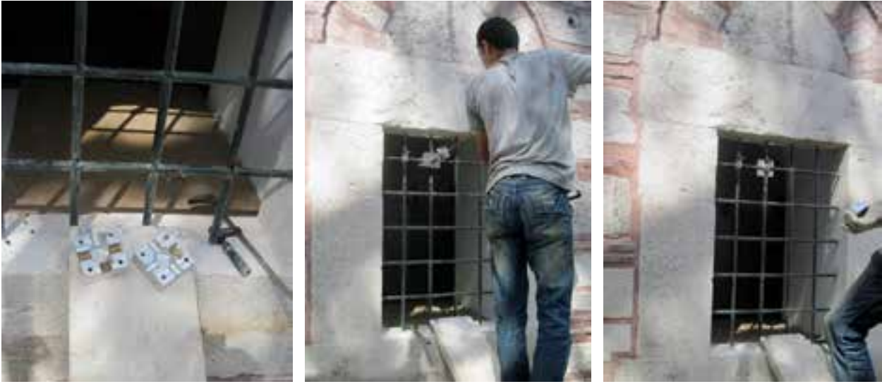
Fotoğraf 72-73-74. Kurşun ile yeniden lokmalı parmaklık yapılması
