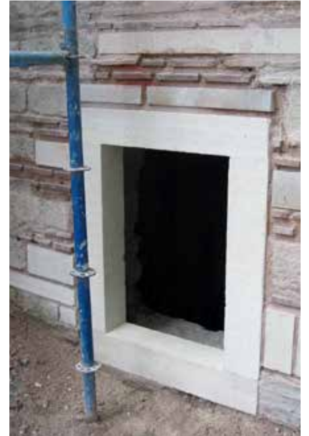
Fotoğraf 50-51. Hasarlı taşların değiştirilmesi
