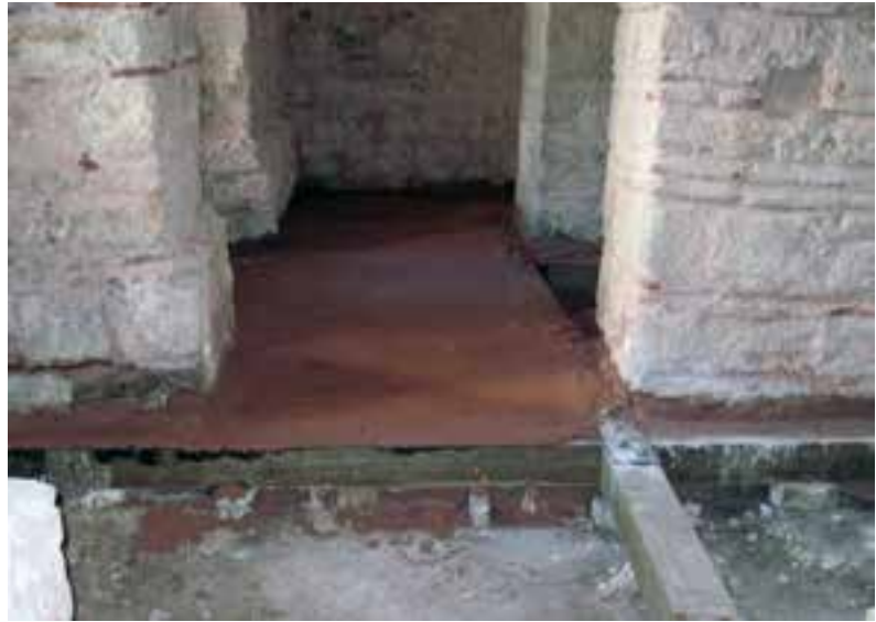
Fotoğraf 18-19. Bodrum kat döşeme altında yapılan ahşap hatıl sistemi
