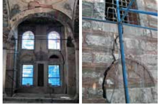
Fotoğraf 38-39. Kuzeybatı-güneydoğu doğrultusunda meydana gelen ayrılma ve cepheye yansımaları
