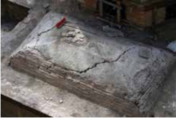
Fotoğraf 37. Tonoz üzerinde çökme
