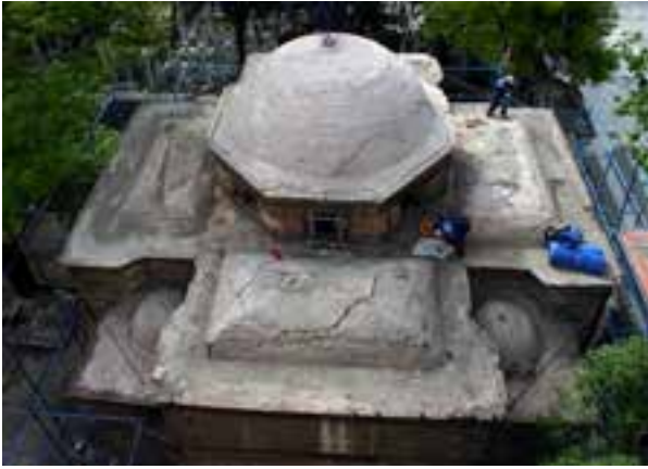
Fotoğraf 35. Üst örtü sistemindeki çatlaklar
