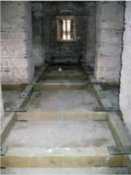
Fotoğraf 17. Üst örtü üzerinde çıkan ahşap hatıl yuvaları
