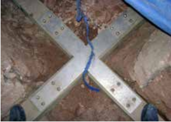
Fotoğraf 25-26. Üst örtü üzerinde yapılan ahşap hatıl sistemi ve birleşim detayları
