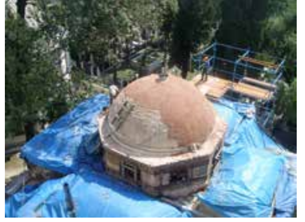
Fotoğraf 47. Horasan sıva yapılması
