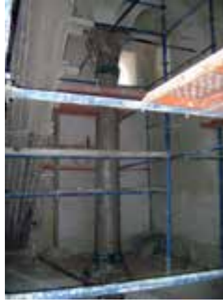
Fotoğraf 58-59. Mermer sütunlarda AB57 ile temizlik yapılması
