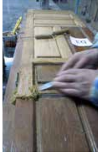
Fotoğraf 64-65. Ahşap kepenkler üzerinden mevcut cilanın çıkarılması
