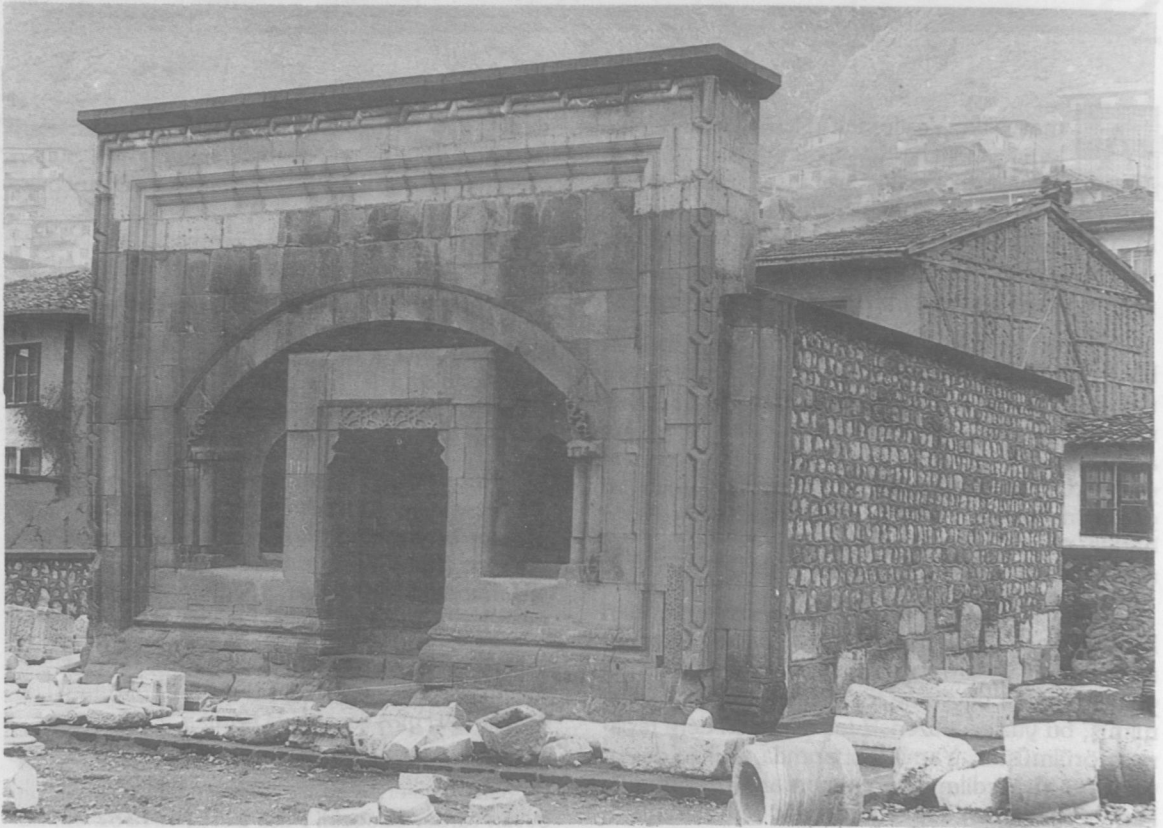
Res.1: Amasya Sultan Mesud Türbesi.
