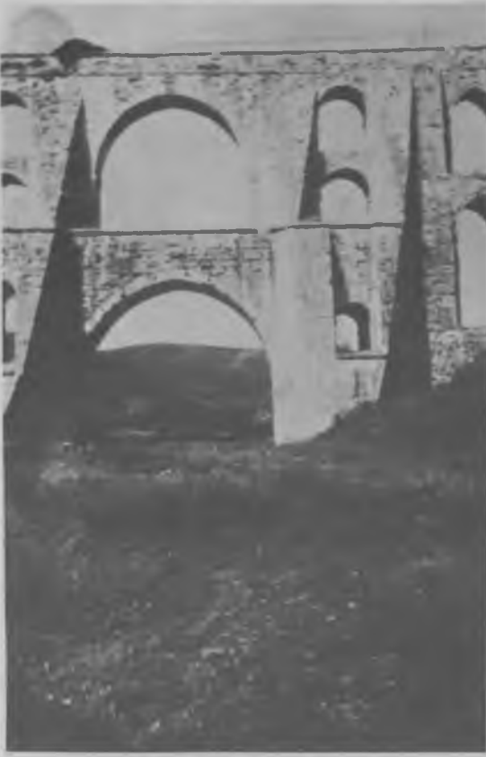
RESİM. 8 İstanbul Kırkçeşme suyu tesislerinden Mağlova Kemer (E.H. Ayverdi'den)
