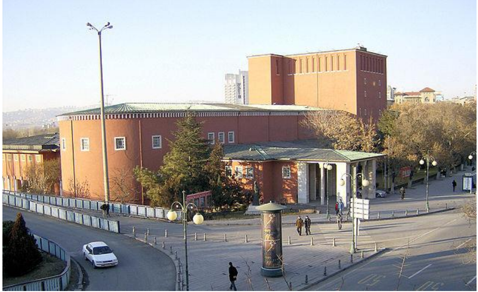
Şekil 2.10 Ankara Opera binası Dış Cephe Görünümü
