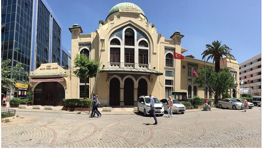
Şekil 2.19 İzmir Devlet Opera Dış Görünüşü
