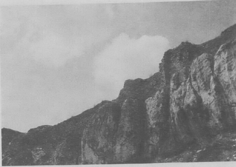
Res. 15: İç kale doğu sur duvarları.
