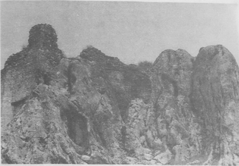
Res. 19: İç kale güneybatı köşe sur duvarları.
