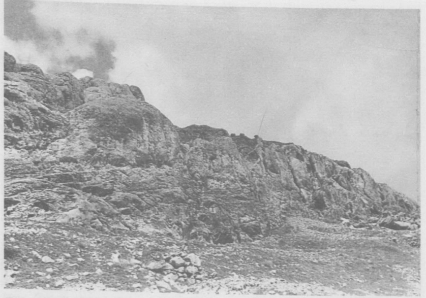
Res. 18: İç kale güney sur duvarları.
