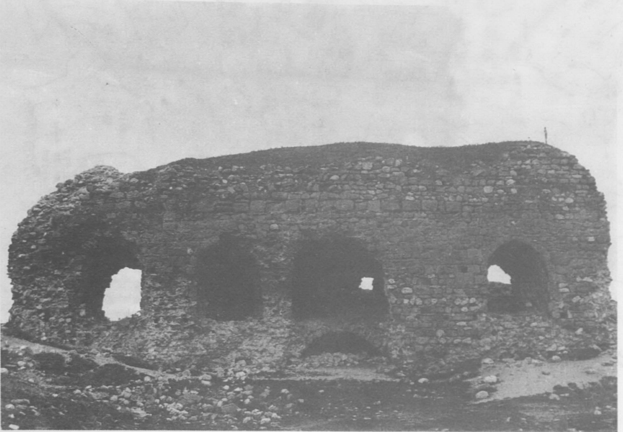
Res. 31: İç kale içinde yer alan mimari mekan.
