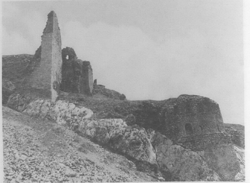
Res. 22: İç kale batı sur duvarları.
