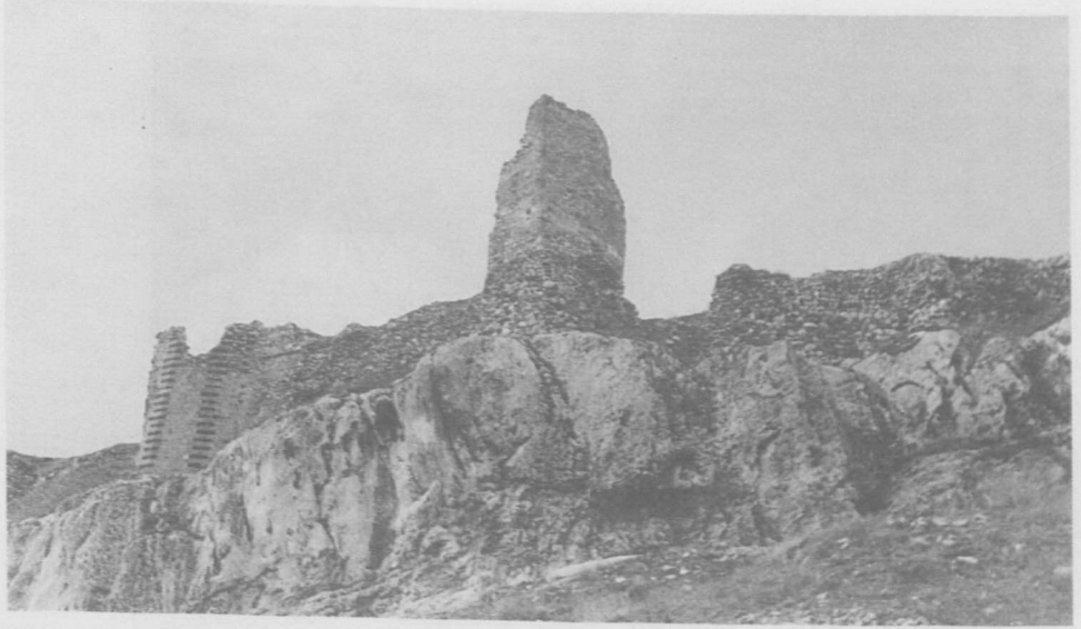
Res. 12: İç kale doğu sur duvarları.
