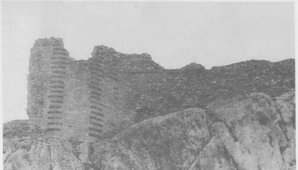
Res. 14: İç kale doğu sur duvarları.
