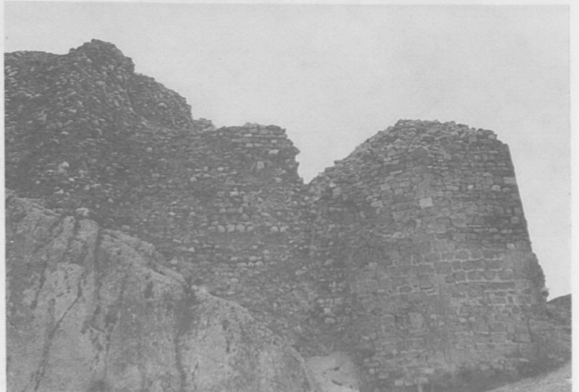
Res. 26: İç kale ikinci girişten sonra doğu'da yer alan sur duvarı.
