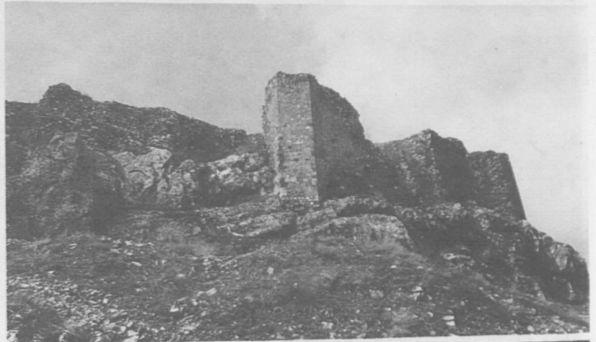
Res. 9: İç kale doğu sur duvarları.
