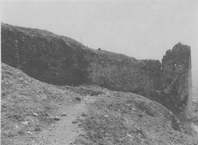
Res. 29: İç kale batı sur duvarları.
