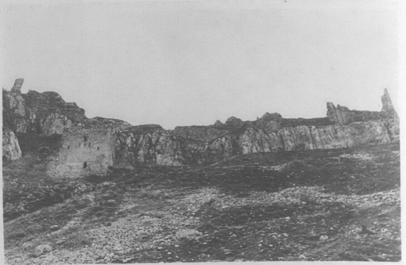
Res. 16: İç kale doğu sur duvarları ve Meryem Ana Kilisesi.
