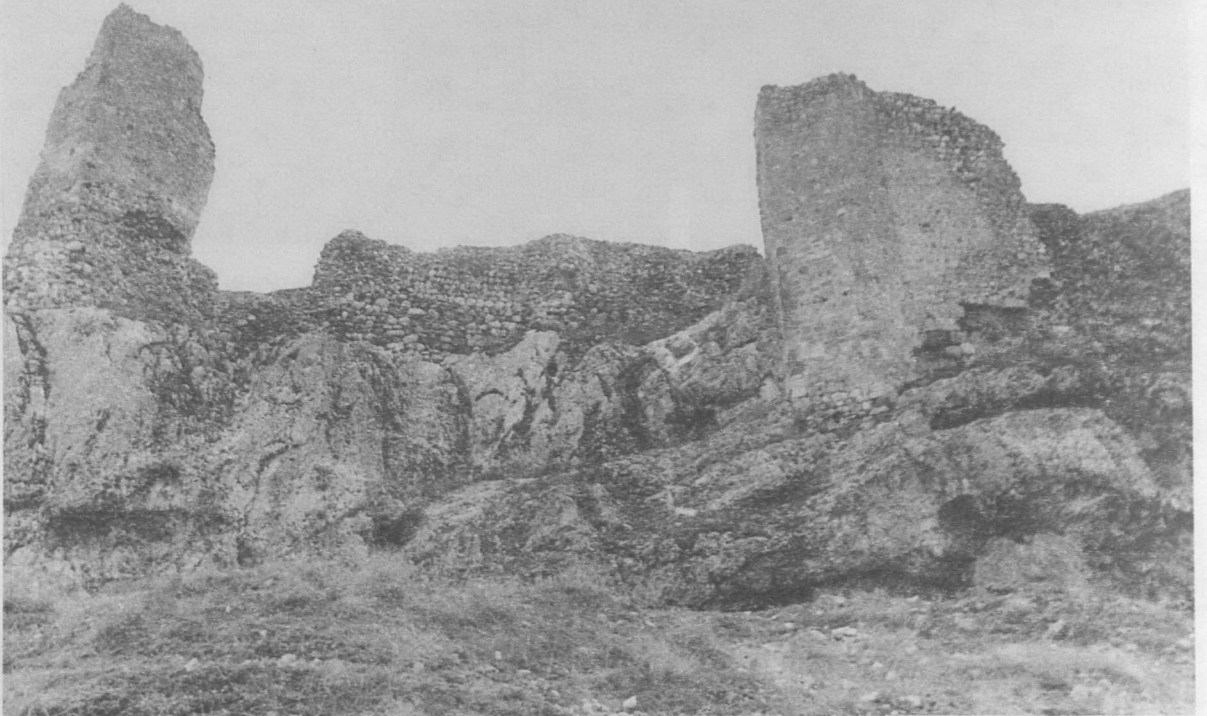
Res. 11: Iç kale doğu sur duvarları.
